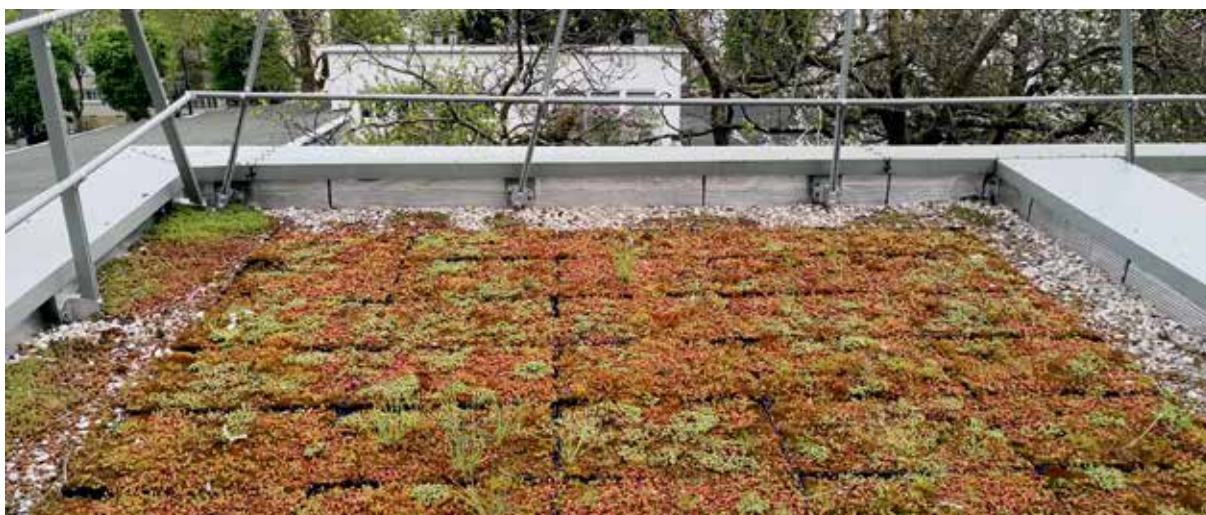
Certains systèmes de végétalisation, à l'instar de cette toiture végétalisée en caissettes pré-cultivées, sont souvent conçus en kit et « copiés-collés » d'une ville à l'autre. ©Marc Barra/ARB ÎdF
