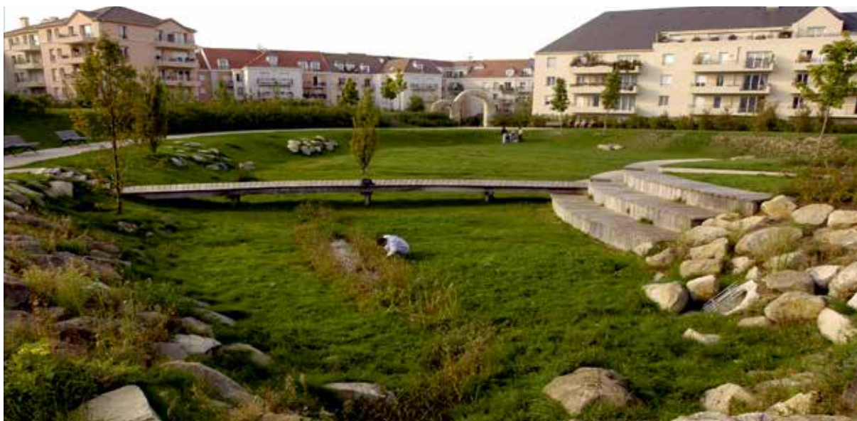
Création d'un jardin inondable pour gérer les eaux pluviales à la parcelle au sein du quartier du Clos Saint-Vincent à Noisy-le-Grand. ©Département de Seine-Saint-Denis
