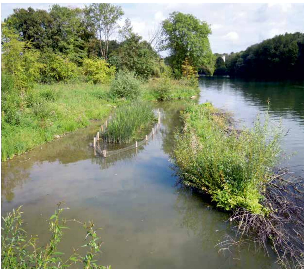
Techniques de génie écologique utilisant le végétal pour la restauration de berges. ©Gilles Lecuir/ARB ÎdF
