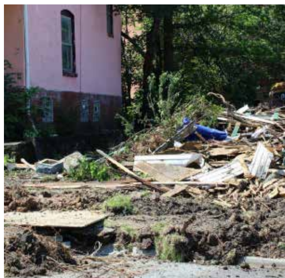
Démolition de bâtiments à Cleveland. ©Turo and Gardiner, 2020 [28]
