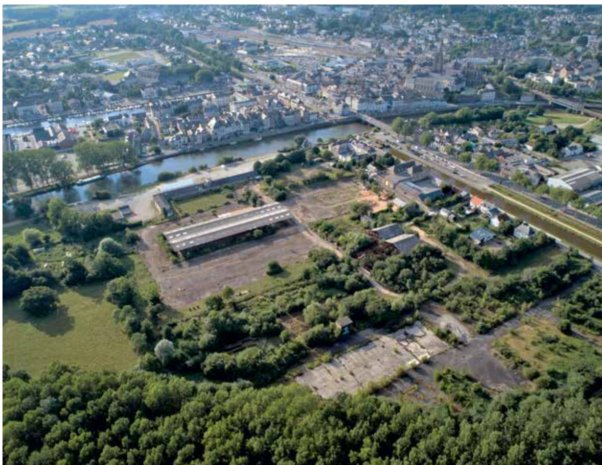
Le Transformateur de Saint-Nicolas-de-Redon est un projet de renaturation d'une friche par les habitants et habitantes du territoire. ©Christian Baudu - Scopidrone
