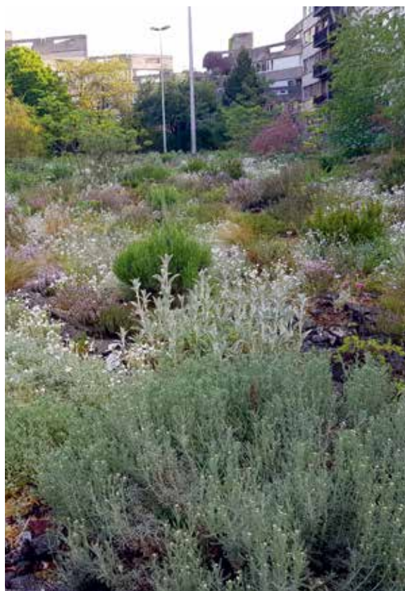
Réalisation des premiers travaux sur l'ancien parking : concassage du béton et plantations. ©Wagon landscaping
