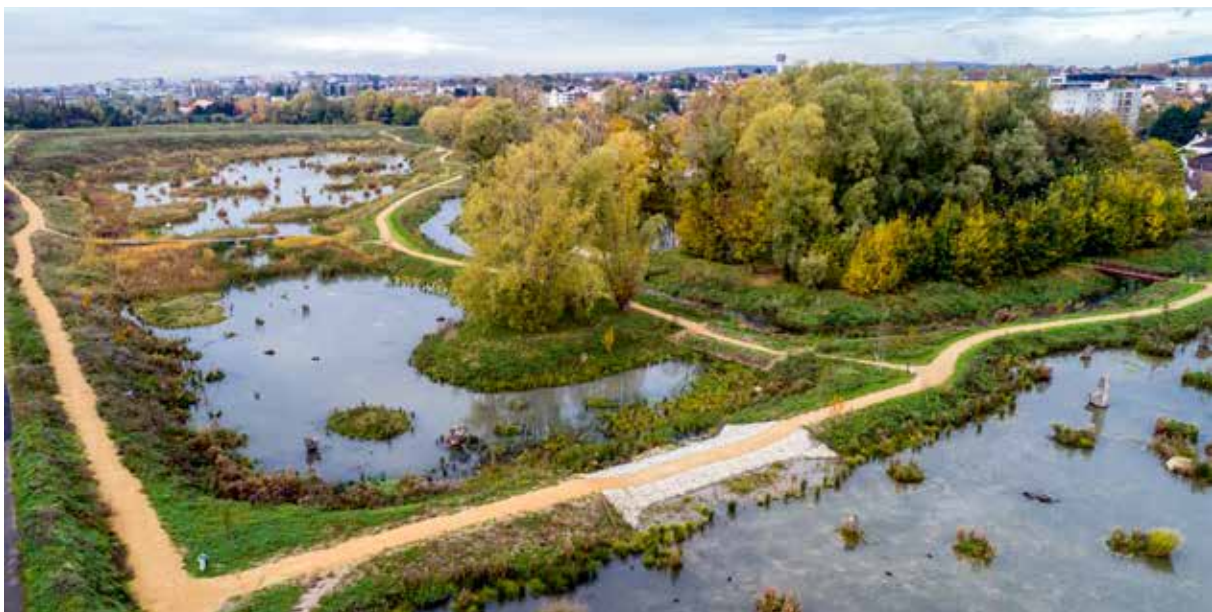
Zones humides permanentes et temporaires présentes sur le site du Vignois devenu une zone d'expansion de crues. © SIAH Crout et Petit Rosne
