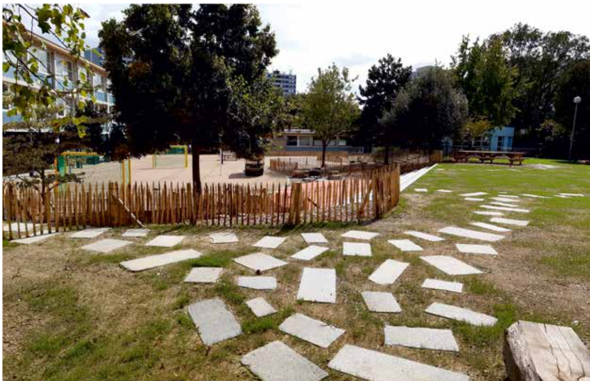
Désimperméabilisation de la cour d'école de l'Ille. ©RM
