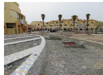
Désimperméabilisation en zone urbaine (Port-Leucate) © Cerema
