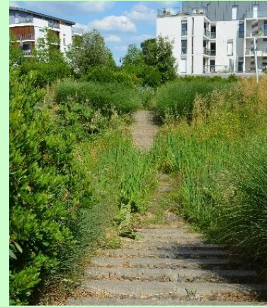
Jardin de pluie accessible par un cheminement en cœur d'îlots © Cerema
