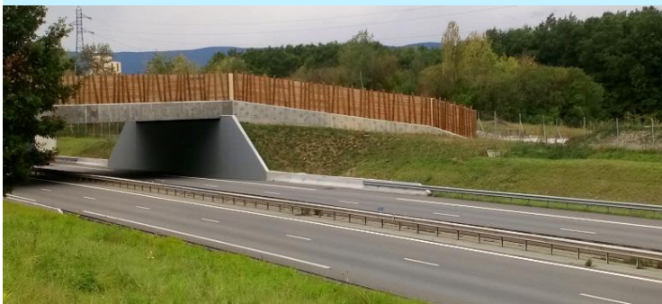
Ecopont de Viry, au-dessus de l'A40 © Cerema
