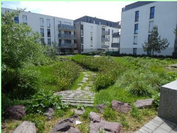
Jardin de pluie accessible par un cheminement en cœur d'îlots avec des dalles en pas japonais © Cerema
