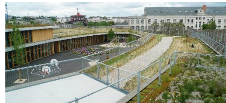
Toiture végétalisée, centre scolaire Aimé Césaire à Nantes © CAUE 44
