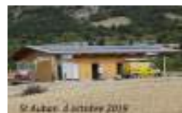
Photographie – SAS Sud Baronnies Salle d'abattage à Saint-Auban-sur-l'Ouvèze
