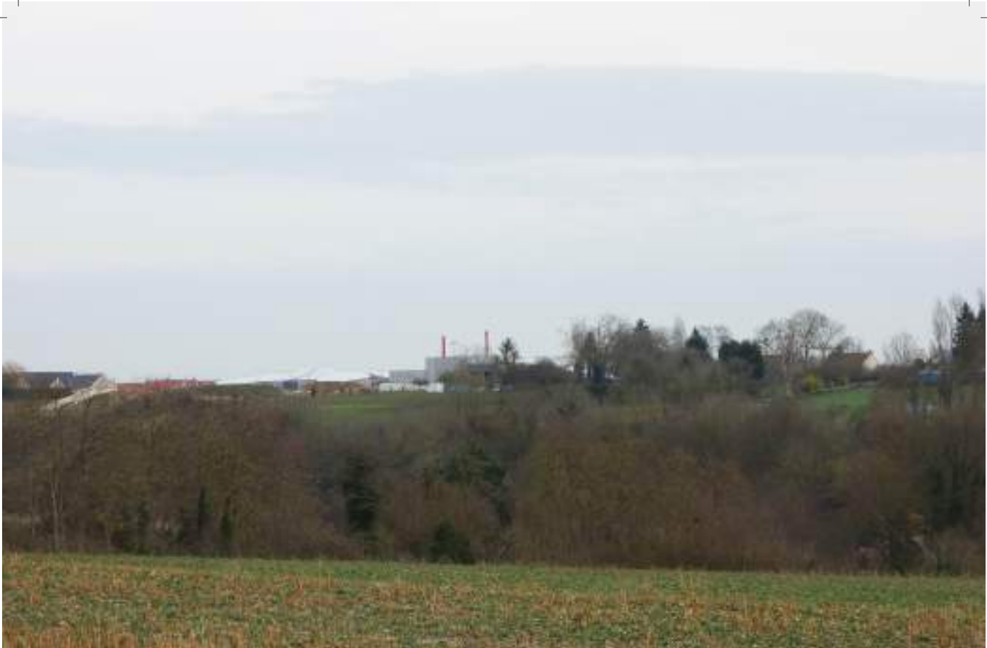
La nouvelle chaufferie biomasse + gaz depuis la plaine au nord
