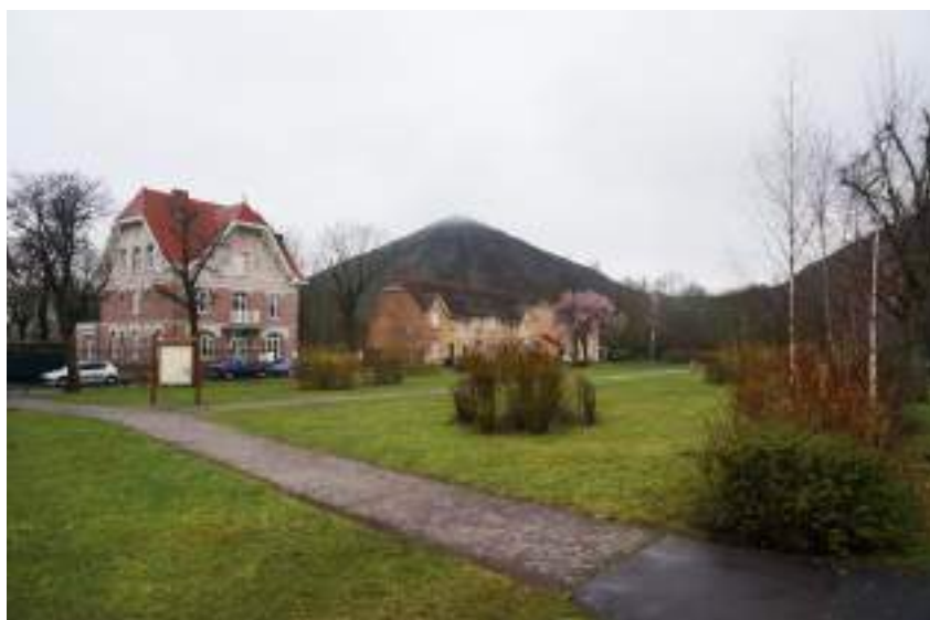
Maison démonstratrice du projet Réhafutur à Loos-en-Gohelle. L'objectif est de proposer des solutions de rénovation de l'habitat minier avec de hautes exigences énergétiques, environnementales, économiques et sociales.
