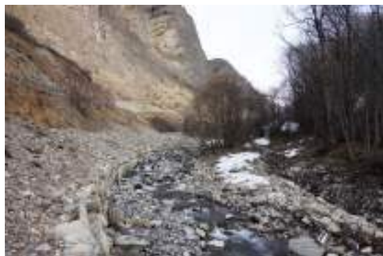
Mur de soutènement avec la pose en enterré de la canalisation entre le torrent et la route départementale
