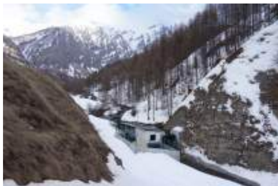
L'ouvrage de la prise d'eau
