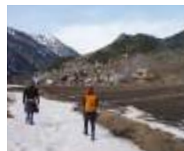
La conduite forcée sous la piste d'accès aux jardins
