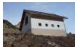
Le bâtiment de la microcentrale en entrée de village
