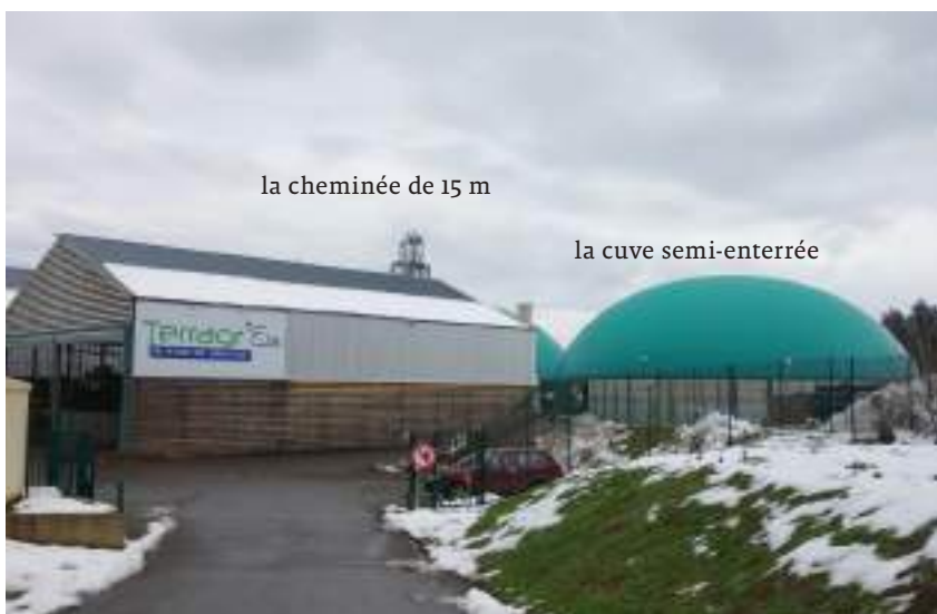
Des travaux de déblais et de remblais sont réalisés, afin d'enterrer partiellement les cuves. La hauteur maximale de l'ensemble des bâtiments doit s'aligner sur celle de la cheminée de 15m.
