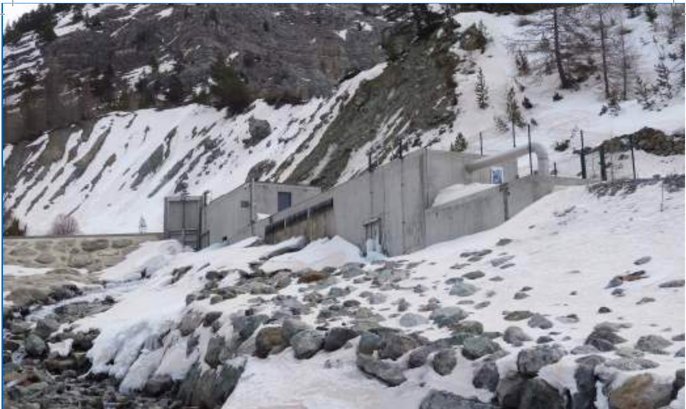
Le mur de barrage et le bâtiment de la prise d'eau
