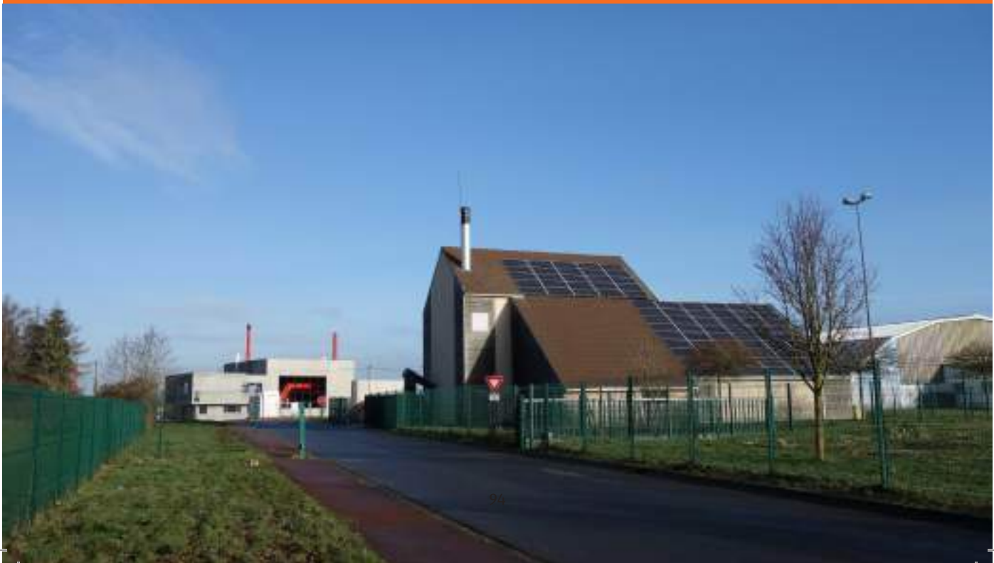
L'ancienne chaufferie biomasse, toujours en activité et ses panneaux photovoltaïques
