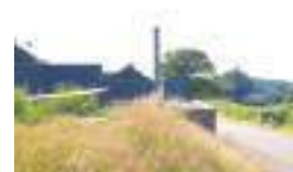
Bâtiment de la chaufferie communale de Glux-en-Glenne
