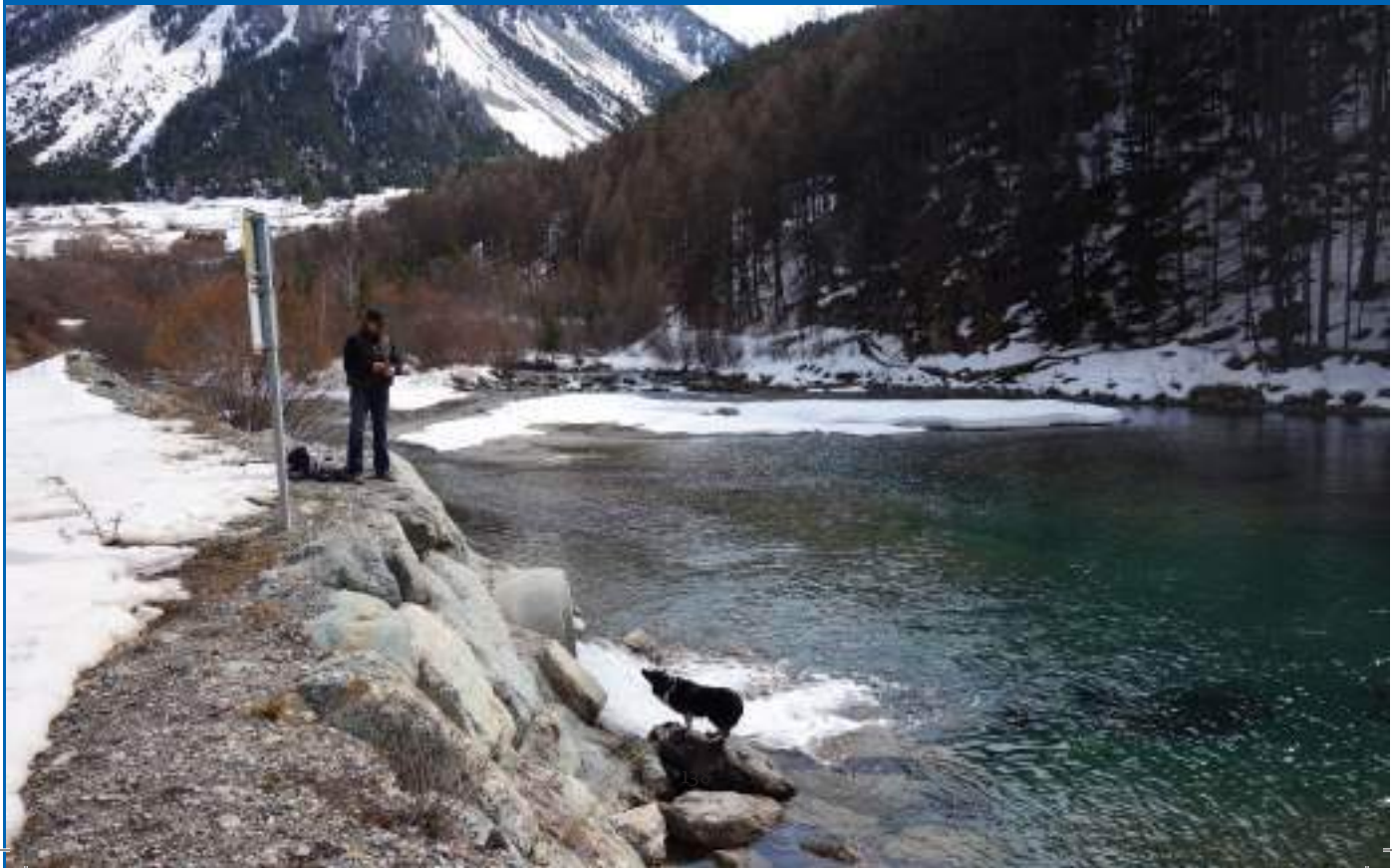
Prolongement du muret de soutènement existant
