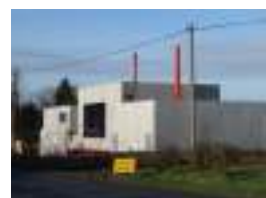
La nouvelle chaudière biomasse + gaz le long de la route départementale
