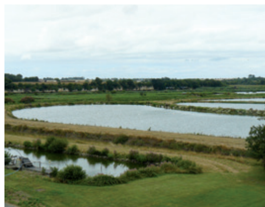
Les différentes composantes de la station de traitement (source : Cerema (Direction territoriale Sud-Ouest))
