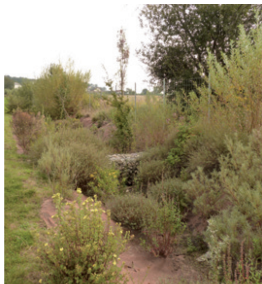
Noue drainant la zone artisanale (source : Cerema (Direction technique Territoires et ville); conception : Infra Service)
