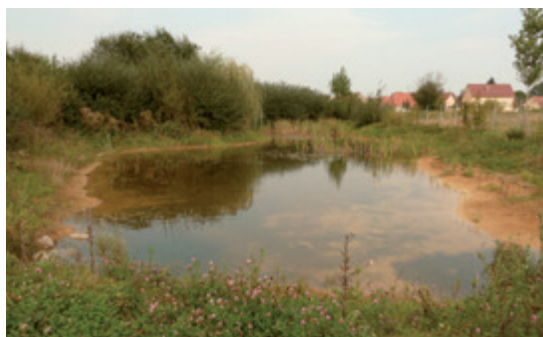
Bassin de stockage des pollutions accidentelles (source : Cerema (Direction territoriale Est); conception : Infra Service)
