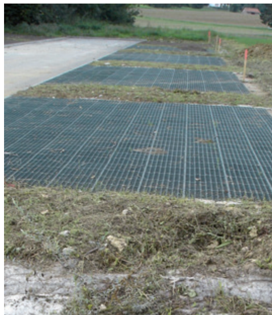
Structure alvéolaire mise en place dans les lotissements (source : Cerema (Direction technique Territoires et ville); conception : Infraservice)
