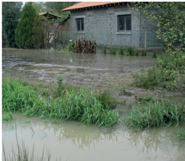
Tarnos sous les eaux dans les années 2000 (source : Tarnos)
