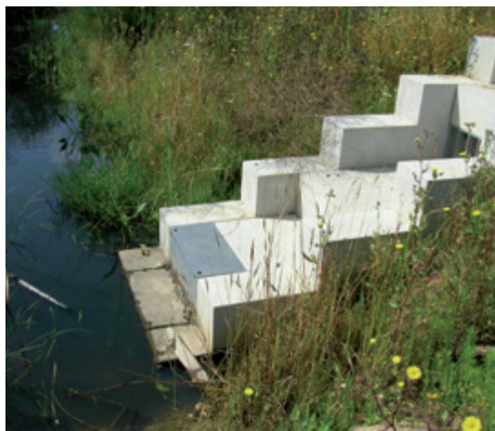
Ouvrage de déversement des eaux pluviales (source : Atelier de paysages Bruel-Delmar)
