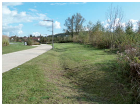
De nombreux aménagements doux favorisant accès au milieu et protection (source: Cerema (Direction technique Territoires et ville); conception: Infra Service)
