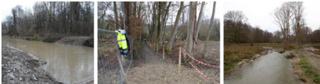
Travaux de renaturation de l'Yvette © Parc Naturel Régional de la Haute Vallée de Chevreuse
