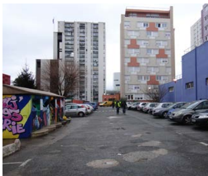
Réaménagement du parking © Fieldwork Architecture
