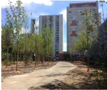
Réaménagement du parking © Fieldwork Architecture
