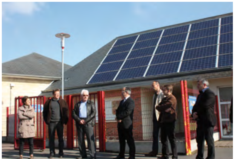
Les mairies de la Communauté de Commune de Plaine Sud de Caen ont mis à disposition les toitures des écoles pour le projet solaire
