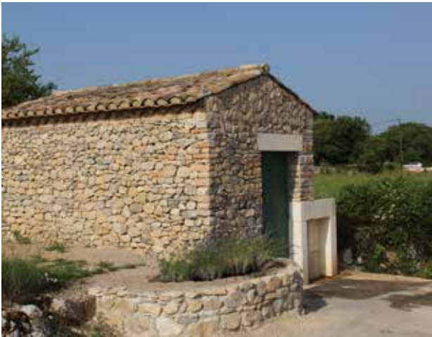
Exemple de poste de livraison dans un cabanon existant
