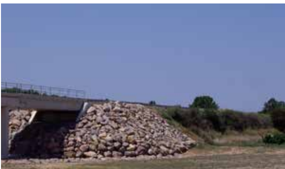
Enrochement incompatible avec le site classé
