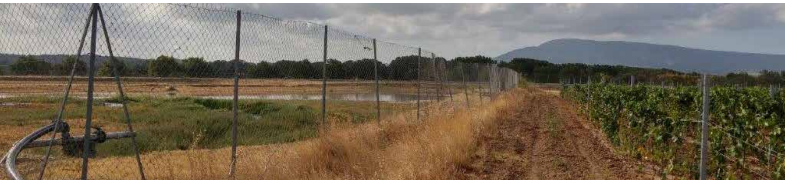
Les clôtures marquent la présence des bassins de rétention.
