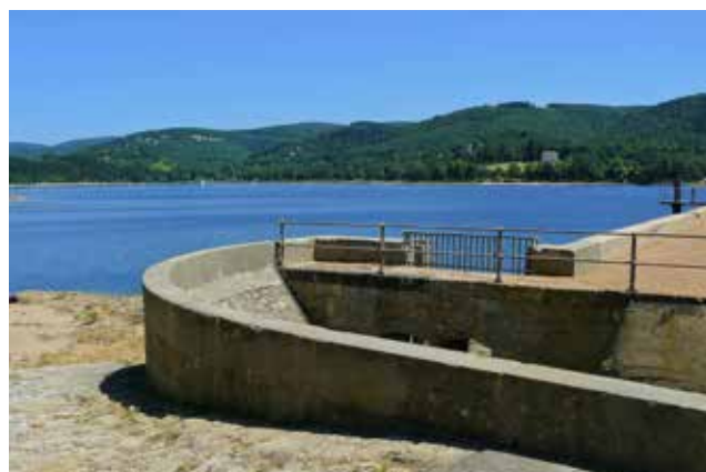
Bassin de Saint-Ferréol
