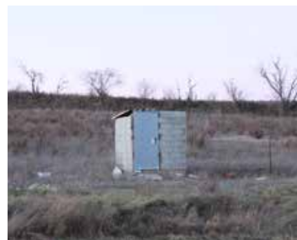
Exemple d'un abri à pompe avec une mise en oeuvre sommaire des matériaux.
