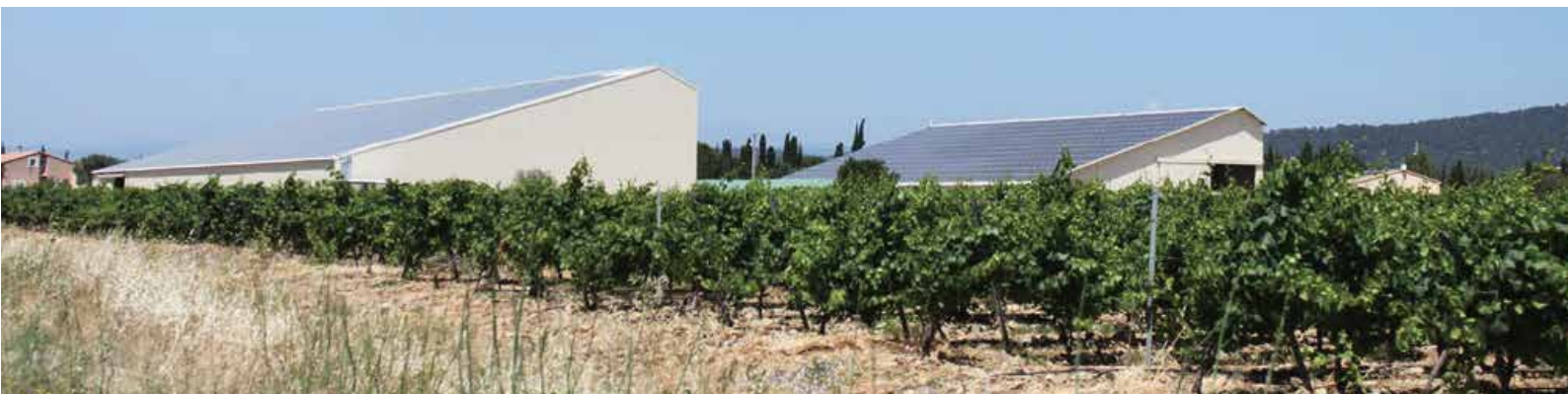
Des hangars photovoltaïques en bordure du canal.
