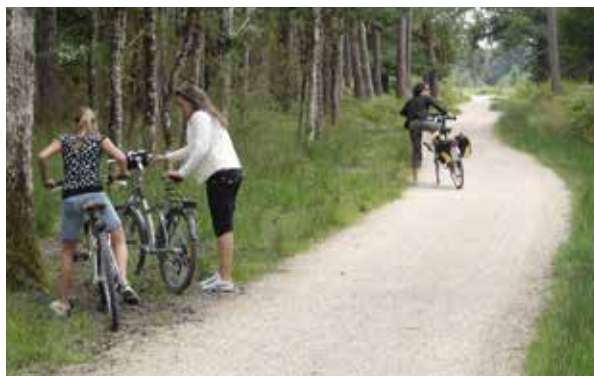
Revêtement perméable en stabilisé calcaire
