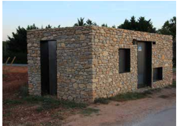
Exemple de poste de livraison en parement pierre
