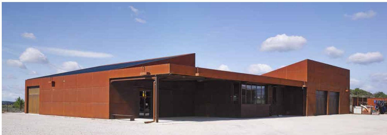
Moulin du Mas Palat / Alain Fraysse Architecte
