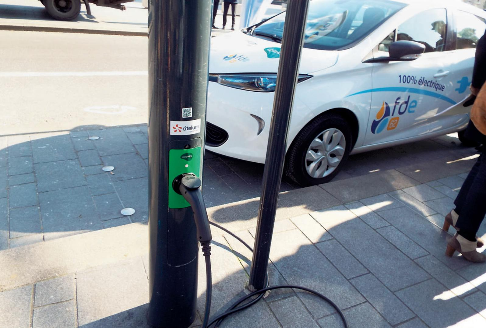
Pour ses lampadaires avec une prise de recharge, la Fédération départementale d'énergie du Pas-de-Calais a soit ajouté un câble, soit équipé le mât d'un interrupteur, soit joué sur les branchements.
