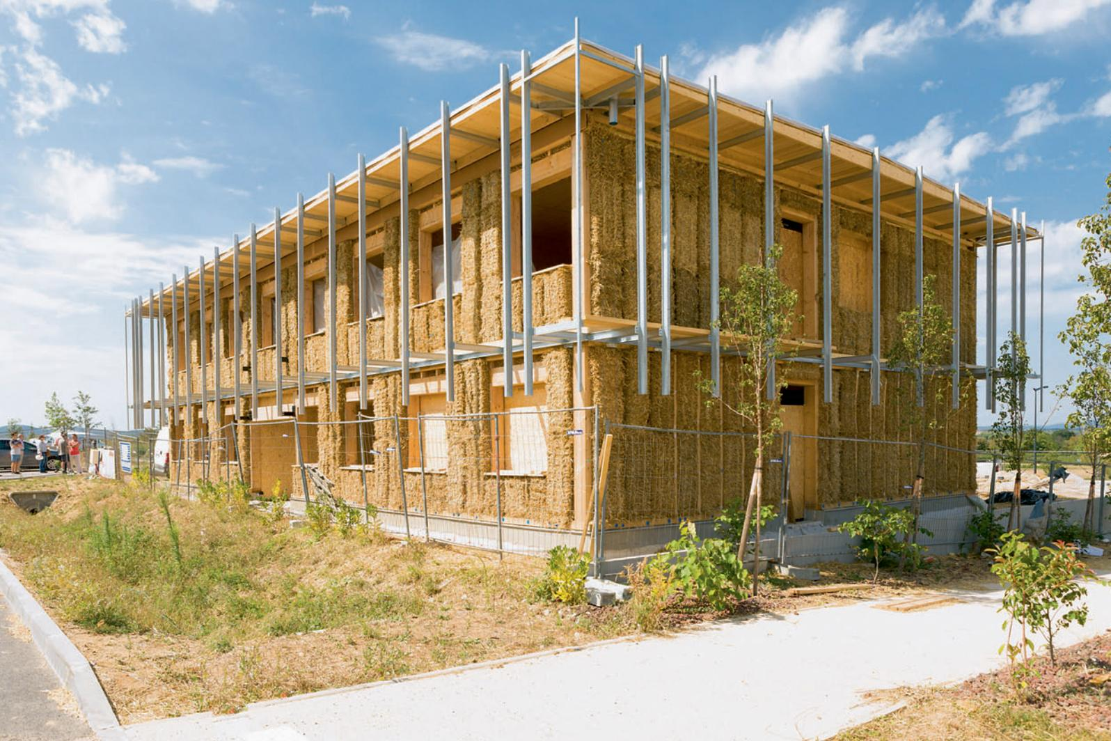
Le siège d'Izuba Energies à Fabrègues (Hérault) comprend une ossature en bois, une isolation en paille et des enduits en terre et paille. S. MORLIER POUR IZUBA ENERGIES
