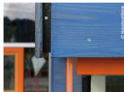
Panneau abouté avec joint ouvert. Le tasseau est peint en noir.
