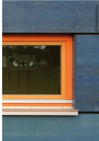
Les panneaux ont été coupés en fonction de la hauteur des fenêtres et rythment parfaitement la façade.
