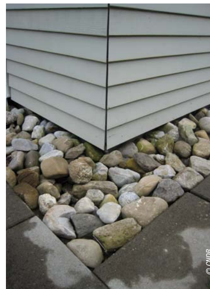
Lames horizontales aboutées avec joint de ventilation.
