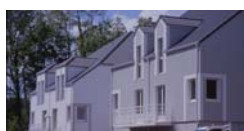
49 logements à Evreux (Eure)
