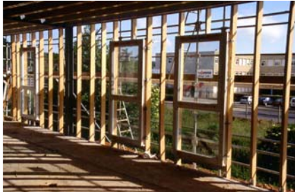
La carcasse métallique réalisée, les corps d'état secondaire interviennent pour réaliser les remplissages.
