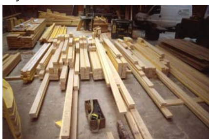
Tous les composants bois sont identifiés et repérés afin de réaliser les panneaux de façade.
