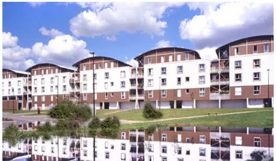
Les vêtements alternent le bac acier laqué et les lames de bois reconstitué Canexel.
