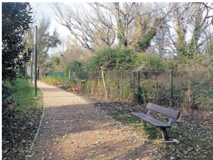
Des cheminements perméables pour les piétons et les vélos photo : ARPE Midi-Pyrénées
