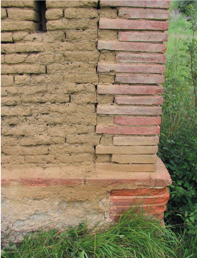
Soubassement en briques de terre cuite
