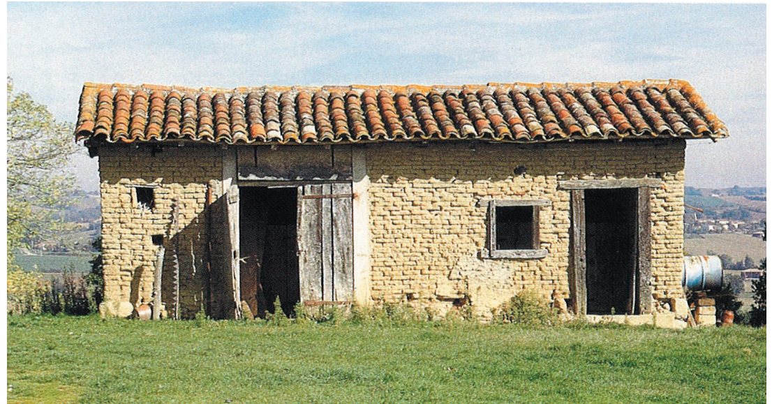
Encadrement de porte et fenêtre en bois
