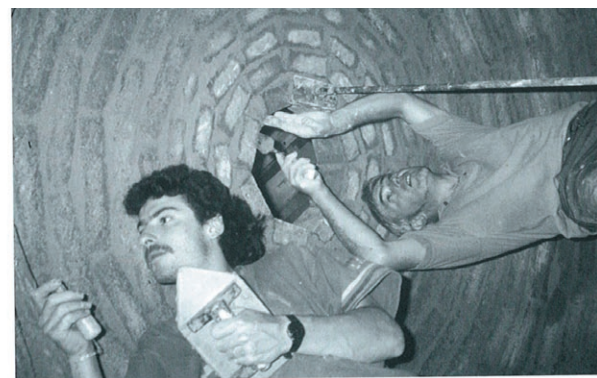
Montage d'une coupole en BTC dans le cadre des chantiers du Centre de terre de Lavalette (voir p. 66).
