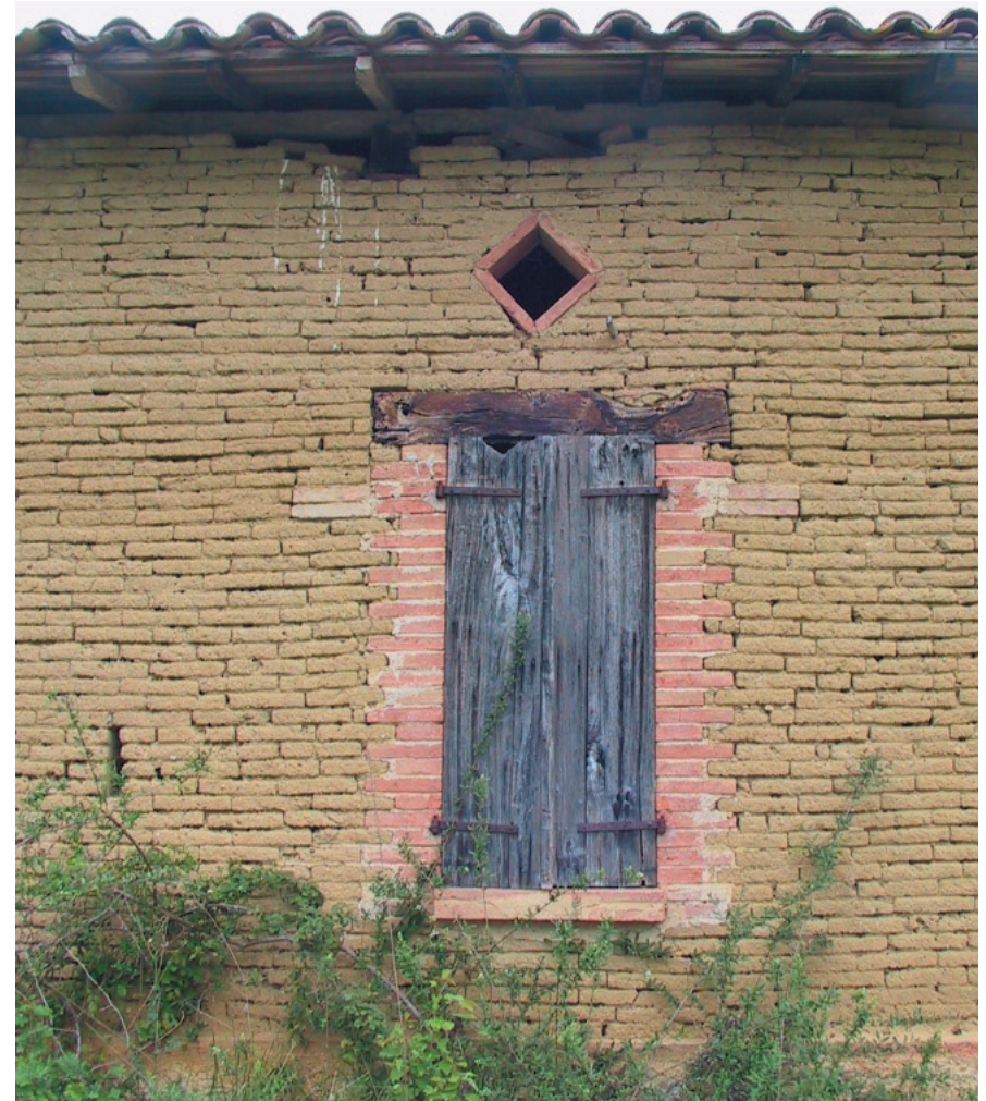
Encadrement de fenêtre en terre cuite et linteau bois
