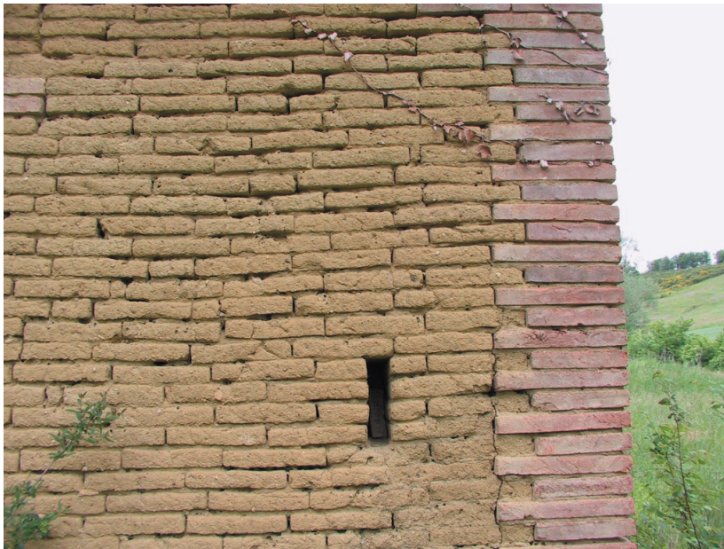
Chaînage vertical en briques de terre cuite
