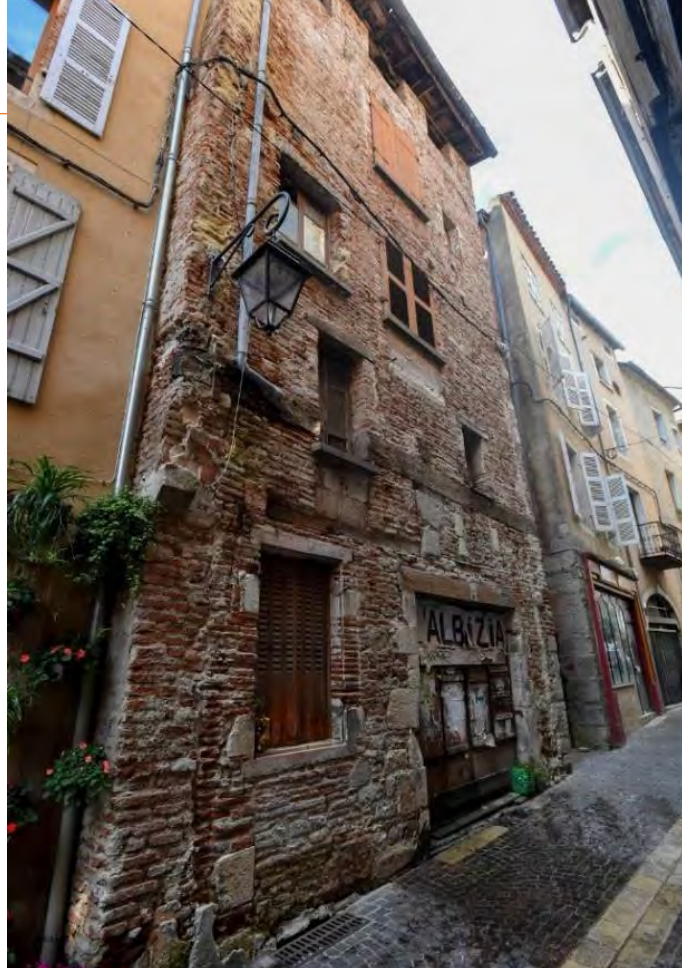
Chantier école à Cahors, démarche Enerpat
