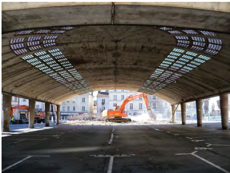
La halle de Fontainebleau en cours de démolition
