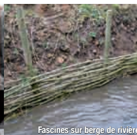
Fascines sur berge de rivière
