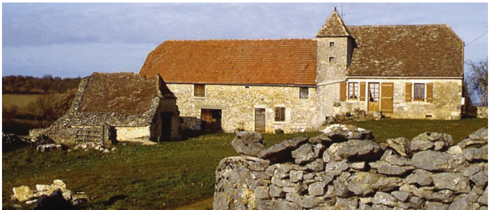
Longère à pigeonnier intégrant un logis, prolongée par des annexes agricoles accompagnées d'un fournil à Carluçet. Ce type construction était bien souvent édifié en plusieurs campagnes qu'une analyse attentive permet d'identifier.
