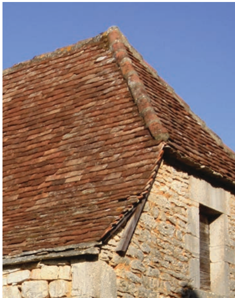
Le passage d'une couverture en chaume ou en lauze à l'emploi de la tuile plate a favorisé l'apparition du coyau sur les toitures traditionnelles
