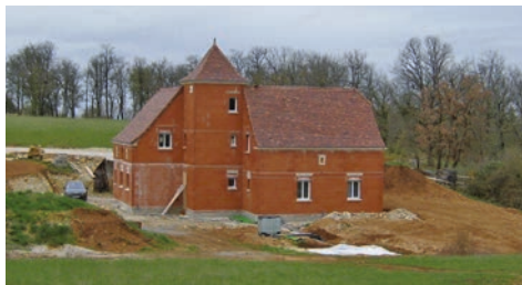
Maison néo-quercynoise en construction près de Gramat
