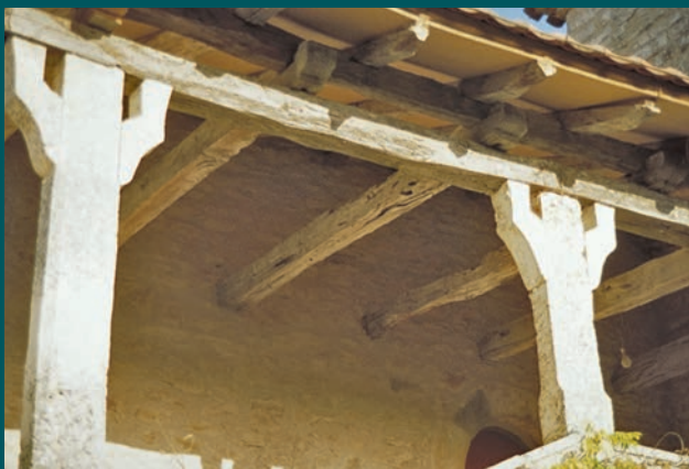
Poteaux de galerie en pierre reproduisant un aisseliers en bois à Limogne
