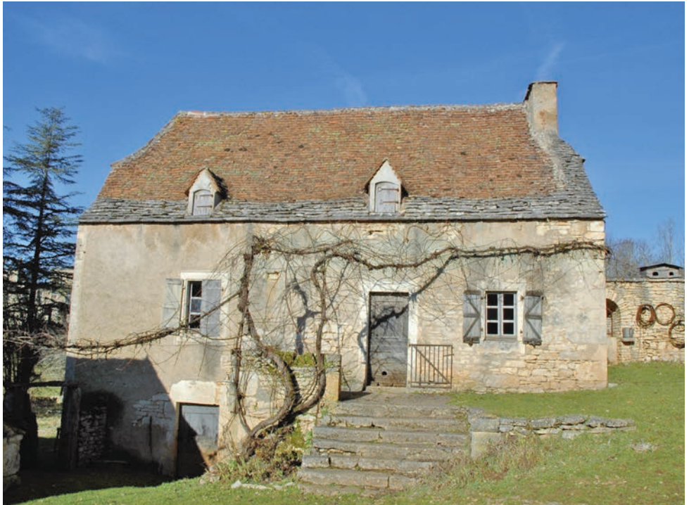
Maison inscrite perpendiculairement aux courbes de niveau offrant des accès de plain-pied aux différents niveaux du bâtiment : cave et habitation (logis de la ferme du musée de Cuzals à Sauliac-sur-Célé)
