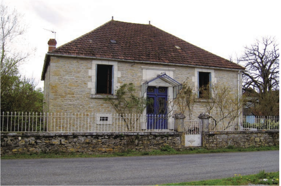
Maison du début du XX e siècle (avant 1920) à Gramat. L'architecture s'appuie encore sur des codes classiques de l'architecture : composition symétrique de la façade, ordonnancement, vocabulaire ornemental des ferronneries et de l'encadrement de la porte...
