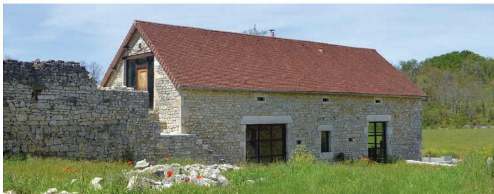
Grange reconverte en habitation à Sènièrgues
