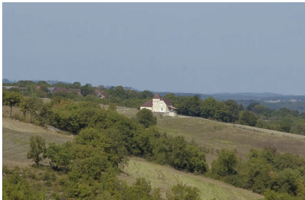
Pavillon isolé dans le secteur de Beaumat illustrant les questions d'urbanisme et de paysage soulevées par la maison individuelle
