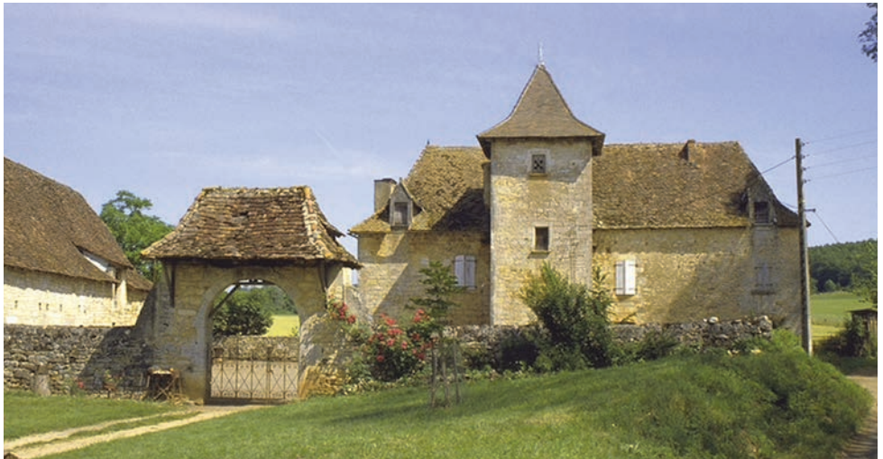
Ensemble rural cossu du Limargue organisé autour d'une cour au Roumégoux à Théminettes. Une grange étable est implantée à l'équerre du manoir ennobié d'une tour carrée et d'une haute toiture à quatre pentes.
