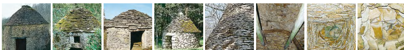
Détail de couvertures de pierre sèche
