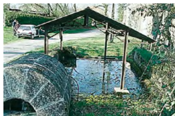
Ribérac, source bâtie en pierre, charpente métallique
