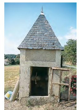
Clermont-d'Excideuil, couverture à quatre pans en ardoise
