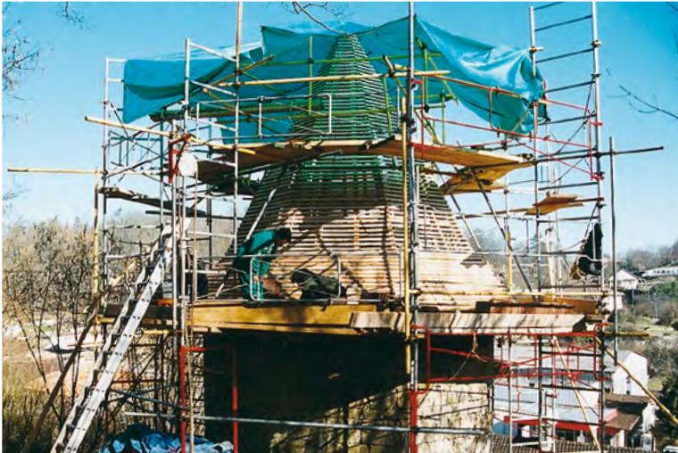
Le chantier de restauration
