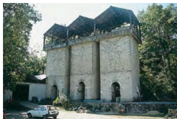
Four à chaux, Saint-Martial-d'Albarède
