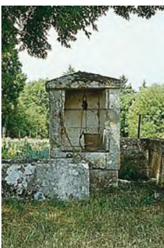
La Rochebeaucourt-et-Argentine, couverture en pierre à quatre pans
