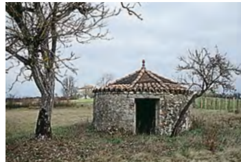
Brantôme, plan circulaire et couverture octogonale
