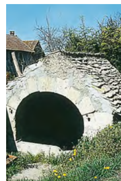
Marcillac-Saint-Quentin, toiture de lauze
