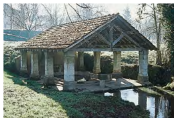
Carsac-Aillac, couverture symétrique soutenue par des piliers de pierre
