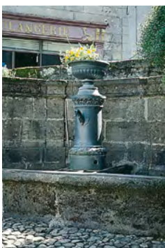
Nontron, fontaine adossée surmontée d'une pompe
