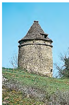
Marcillac-Saint-Quentin, toiture en lauzes
