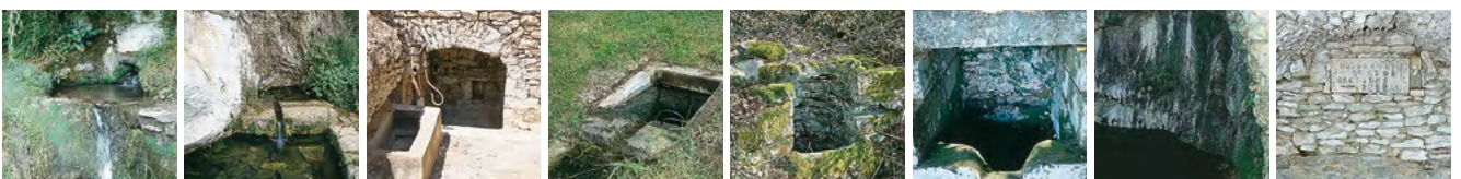
Bassins de puisage ou puits
