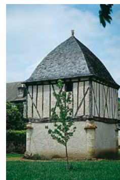
Terrasson, volière en colombage et toiture «à l'impériale»
