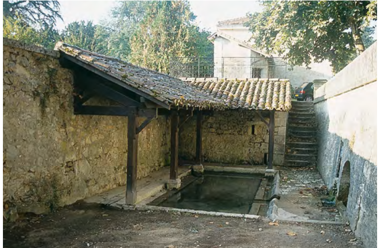
Chancelade, lavoir partiellement couvert en contrebas de la place
