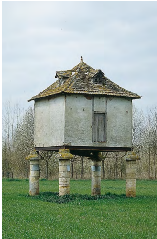
Pontours, colonnes de pierre, volière en colombage et lucarnes d'envol intégrées dans la toiture
