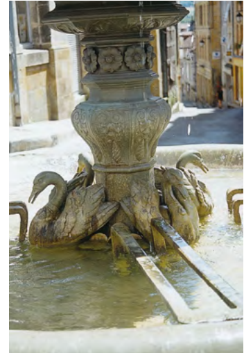
Détail de la fontaine après restauration
