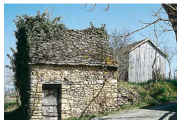
Thonac, cabane avec toit à deux pentes
