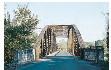
Ménesplet, pont métallique, tablier autoporté
