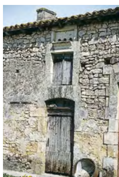
Chapdeuil, composition verticale avec la porte et la fenêtre
