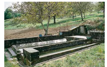
Granges-d'Ans, une source, un bassin de lavage et un
