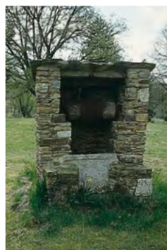
Sarlande, couverture à une seule pente en lauze de schiste
