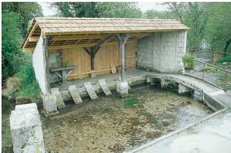
Champagne-Fontaine, lavoir couvert sur une rive
