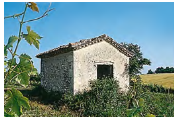
Issigeac, couverture à deux pentes en tuile canal
