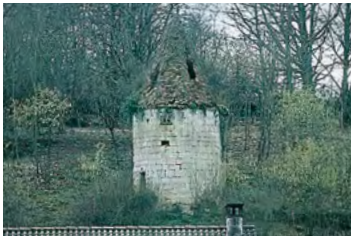
Le pigeonnier avant travaux
