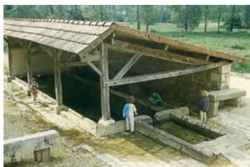
Sainte-Orse, couverture asymétrique sur le bassin de lavage
