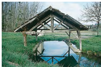
Fossemagne, bassin couvert aménagé sur un ruisseau
