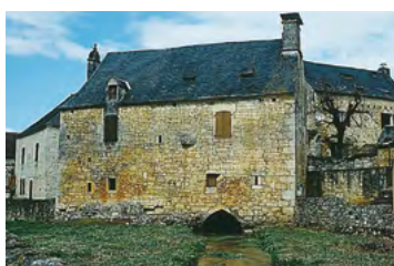
Borrèze, côté évacuation de l'eau
