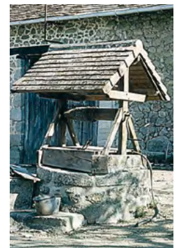
Abjat-sur-Bandiât, puits en granit, toiture en tuiles, abreuvoir contigu
