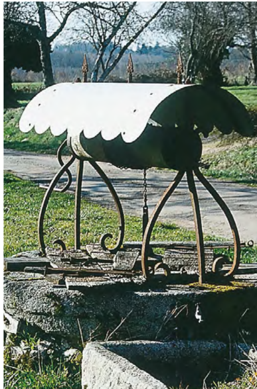
Abjat-sur-Bandiât, puits en granit et chapeau hémicylindrique en tôle
