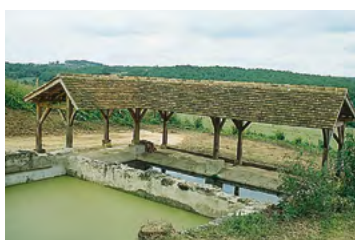
Hautefort, couverture en angle et partielle d'un bassin
