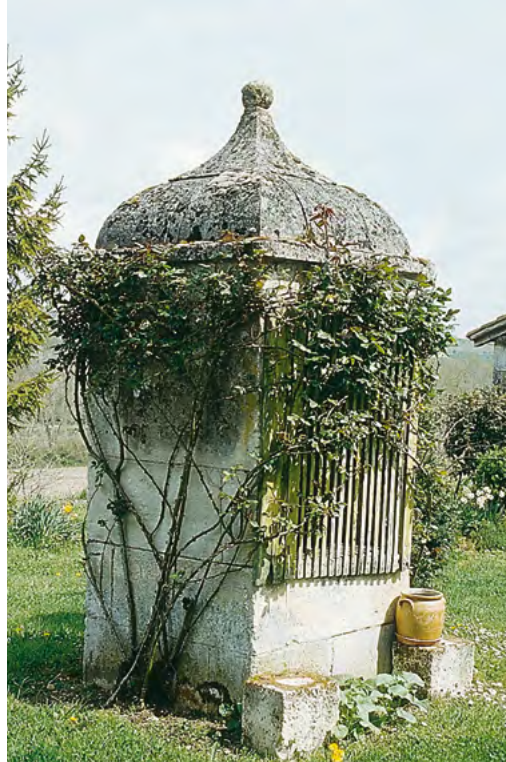
Douchapt, couverture en pierre en forme de bulbe à quatre pans
