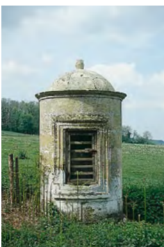
Saint-Germain-et-Mons, construction cylindrique en pierre
