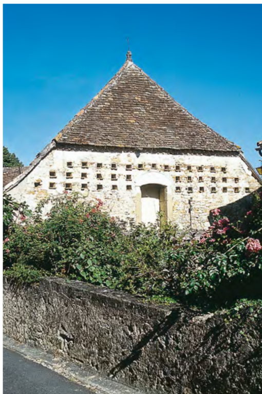
Thenon, planches et trous d'envol en briquettes
