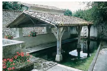
Saint-Privas-des-Prés, lavoir partiellement couvert et clos
