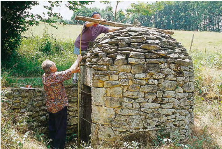
Relevé d'une fontaine bâtie
