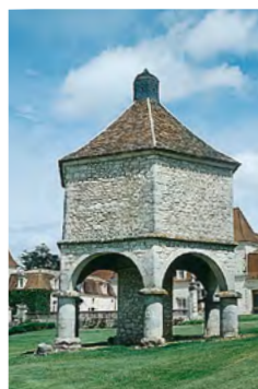
Monestier, double système de protection par chapiteaux
