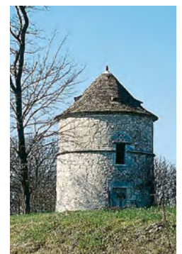
Pomport, pigeonnier ancien moulin à
