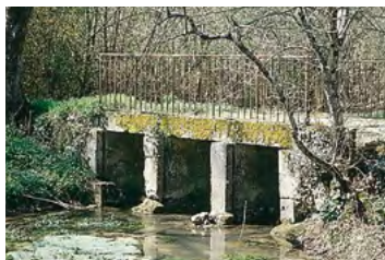
Saint-Laurent-sur-Manoire, pont sur piliers de pierre
