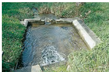
Vieux-Mareuil, bassin aménagé sur le cours d'un ruisseau
