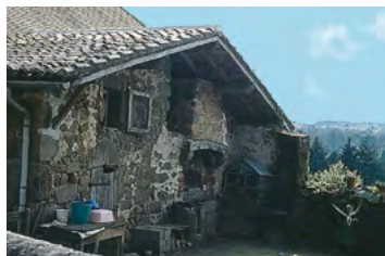
Abjat-sur-Bandiat, large débord de la couverture de la grange faisant office de fournil.
