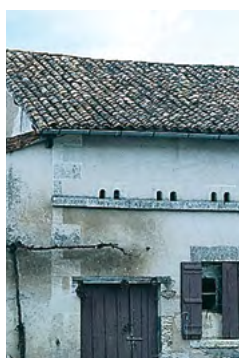
Saint-Privat-des-Prés, alignement de trous jumelés en façade
