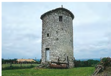
Saussignac, couverture à deux pans remplaçant l'ancienne couverture conique.
