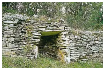
Daglan, guérite avec linteau-couverture en large et épaisse dalle
