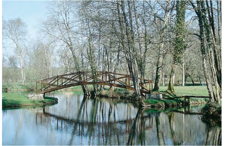
Tocane-Saint-Apre, passerelle piétonne
