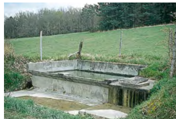
Fossemagne, lavoir en béton utilisant la pente du terrain
