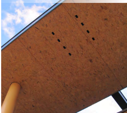
Accès des gîtes à martinets en sous-face d'une avancée
