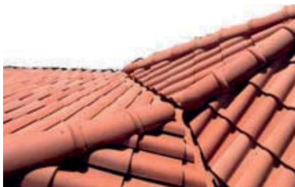
Illustration des points singuliers de couverture (Source FCBA)
