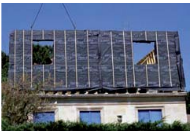
Pose des panneaux à ossature bois sans conservation des pignons (Source FCBA)
