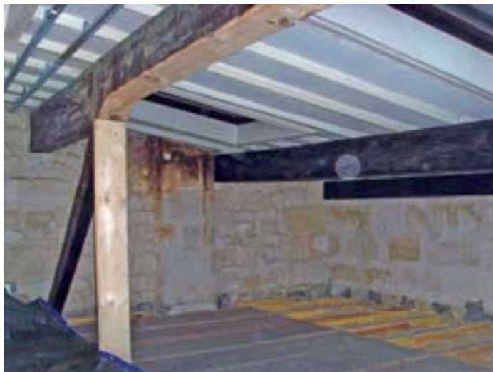
Isolation et modification de la charpente existante (Source FCBA)
