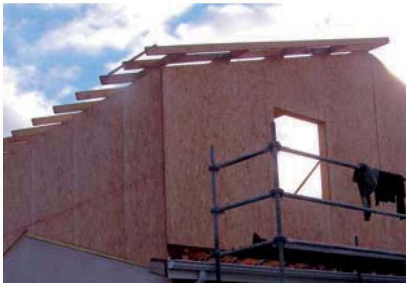
Mise en œuvre d'une charpente traditionnelle (Source FCBA)
