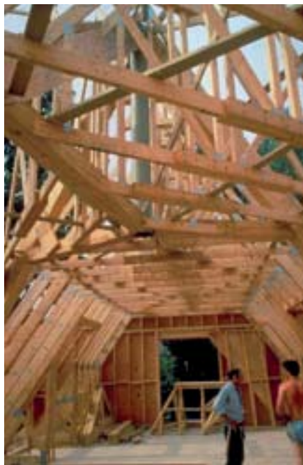
Grenier et charpente industrielle à combles aménageables (Source FCBA)
