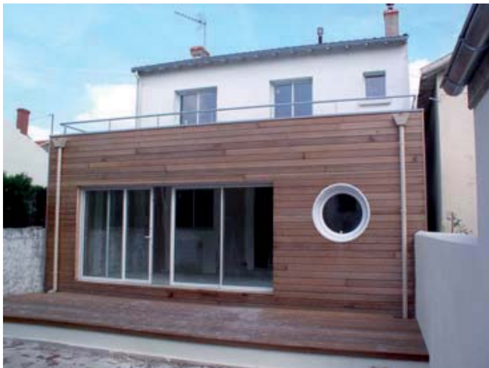
Extension en ossature bois (Source CNDB)
