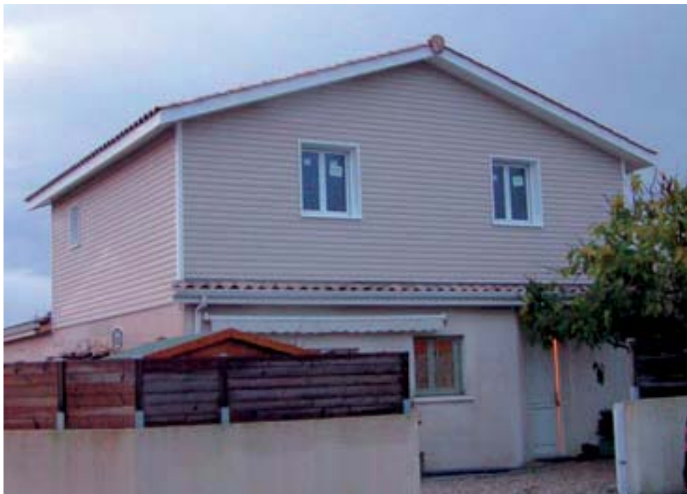
Surélévation partielle d'une maison individuelle (Source FCBA)
