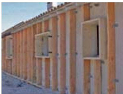
Isolation thermique par l'extérieur (Source FCBA)
