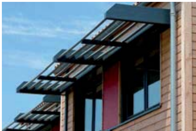
Brise-soleil et débord de toit (Source FCBA)
