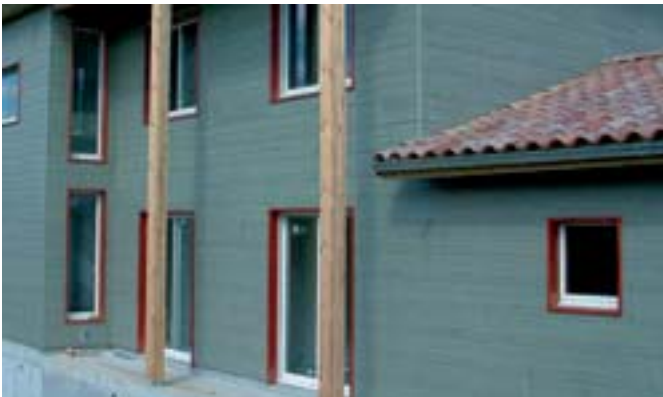
Bardages composites en bois (Source FCBA)
