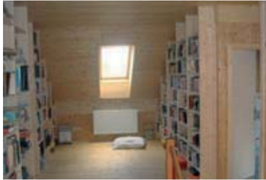
Lambris en plafond, rampant et murs (Source FCBA)
