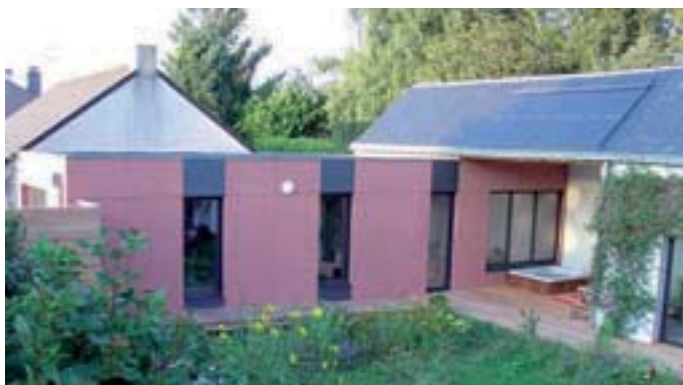
Extension en ossature bois (Source CNDB)
