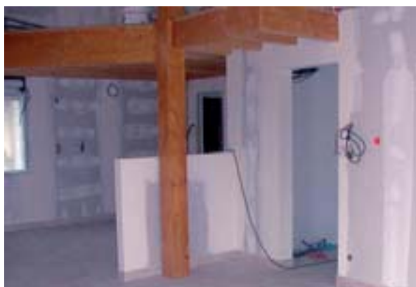
Optimisation de l'encombrement d'une mezzanine (Source FCBA)
