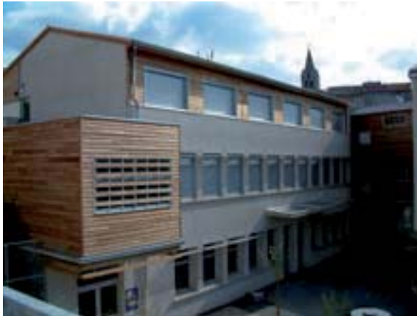
Extension de deux niveaux en ossature bois (Source FCBA)
