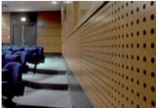
Revêtement intérieur en panneaux (Source FCBA)
