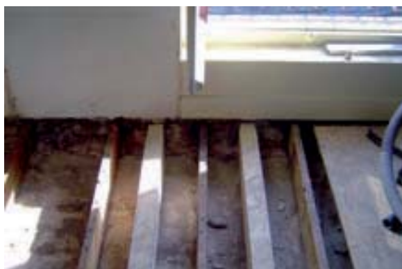
Pose de nouvelles solives sur étriers métalliques (Source FFB-CMP)
