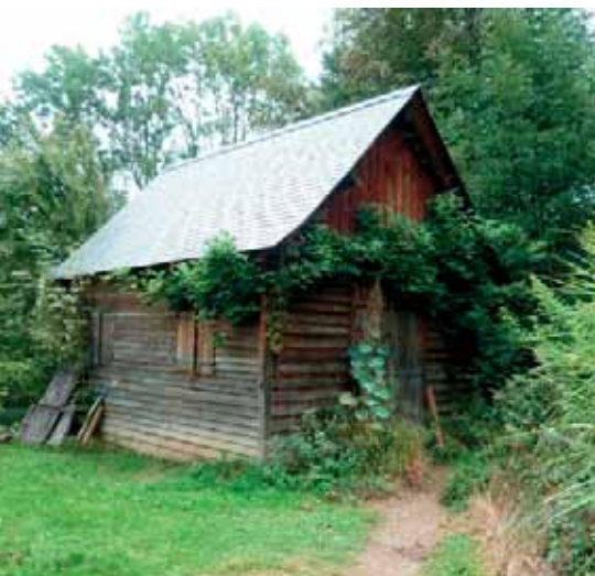
Abri de jardin en bois, végétalisé Les-Bordes-sur-Lez
