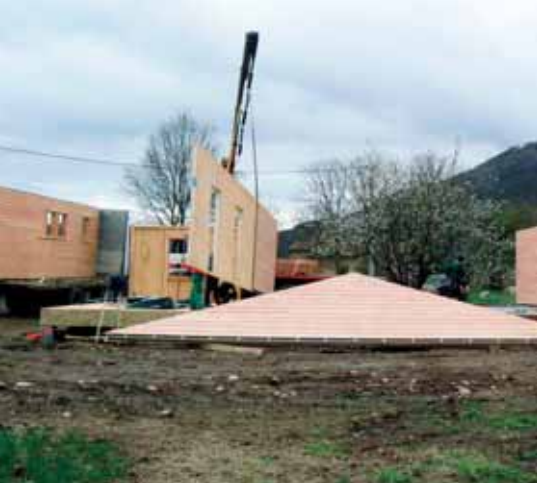
Maison ossature bois - Mise en place des modules façades Montgailhard
