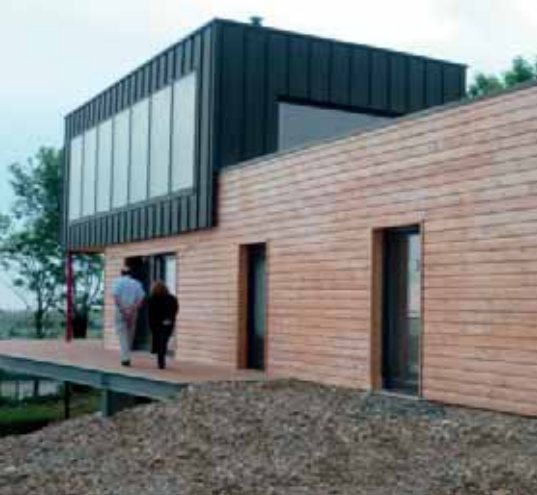
Maison ossature bois - Architecte : Agence POINTE CARRÉE ARCHITECTES, Thierry Chalaux Ecolotissement du Frêne - Laguiole - Aveyron
