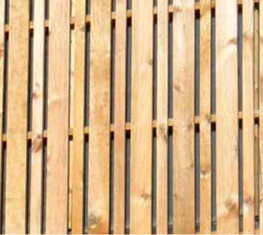
Bardage bois à claire-voie avec pare-pluie Saint-Jean-de-Luz
