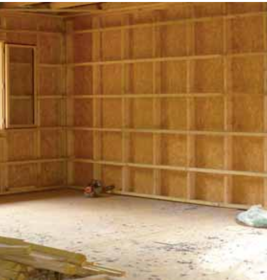
Ossature en attente de recevoir l'isolation Montgailhard
