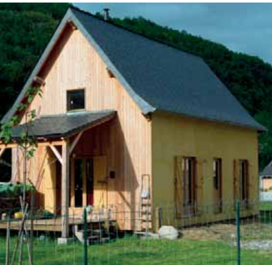
Maison ossature bois - pignons en bois, façades long-pan enduites à la chaux Alas - Balaguères
