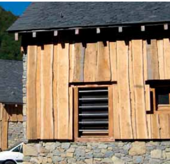
Bardage traditionnel en planches brutes non délignées - Architecte : Henri ANEL Maison du Valier - Les Bordes-sur-Lez
