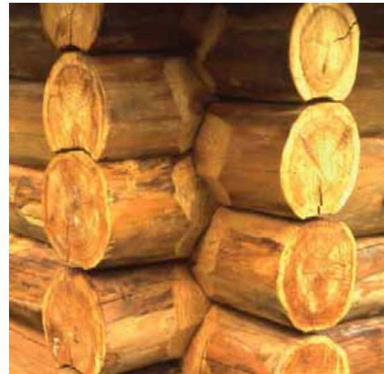
Détail angle de façade fustes
