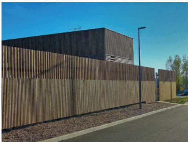
Traitement des limites de propriété, clôture «claustra», réalisé en charpente métallique avec un remplissage à claire voie assuré par la pose verticale de chevrons traités
