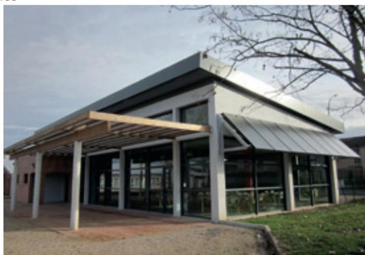
Volume haut, toiture bac acier monopente et surfaces largement vitrées pour la salle de restauration ; panneaux solaires thermiques pour la production d'eau chaude sanitaire
