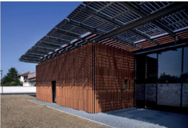
La toiture photovoltaïque, nettement décollée, forme auvent et brise soleil au dessus de l'axe central
