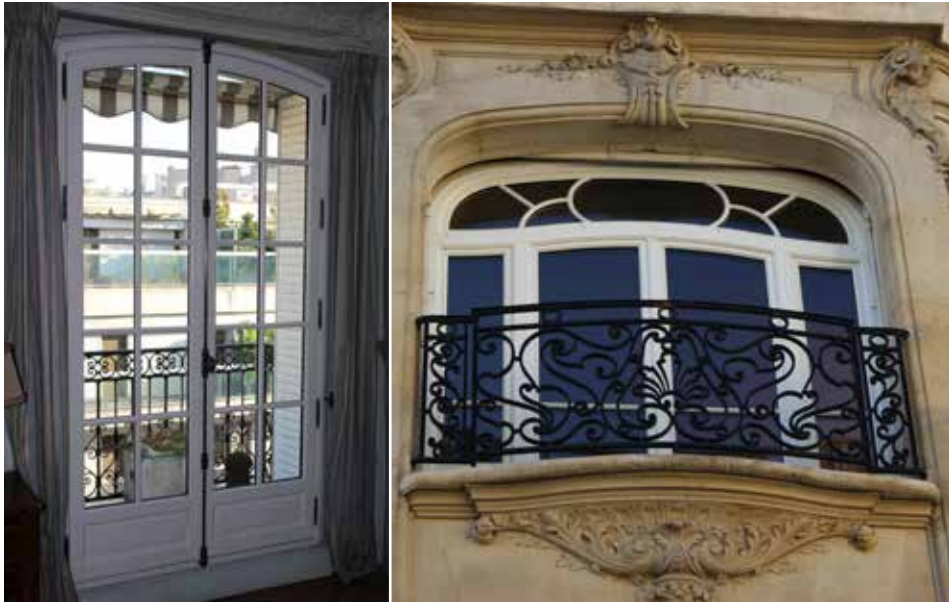
Menuiseries 56 mm traditionnelles type mouton et gueule de loup.
