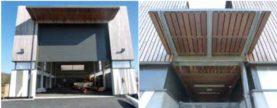
Bardage monolame (section 90 mm x 21 mm), posé verticalement à claire voie.
