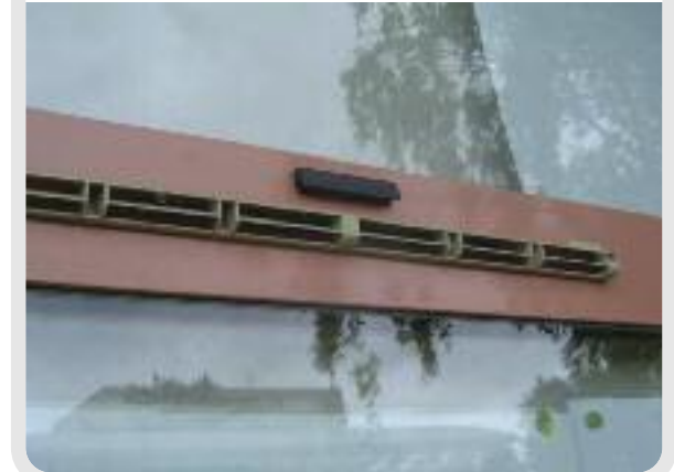
Photo 8 : Entrée d'air dans une fenêtre
