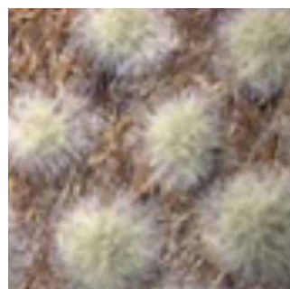
Développement de moisissures grandissement x50
