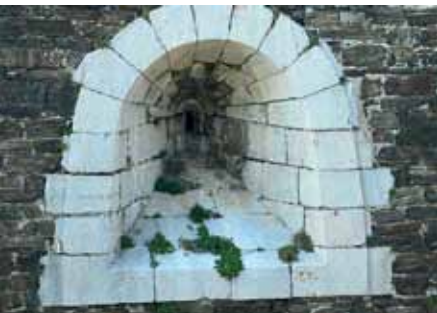
Collioure (66), fort carré : détail d'une ouverture de tir en calcaire blanchâtre à grain fin.
