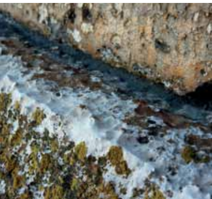
Dissolution de la face supérieure d'une pierre calcaire (amphithéâtre de Nîmes) et colonisations biologiques associées.
