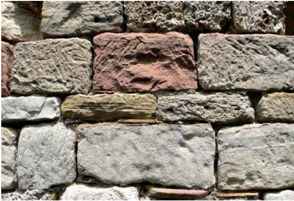
Fozières (34), chapelle : vue du parement avec différentes pierres de remontage.
