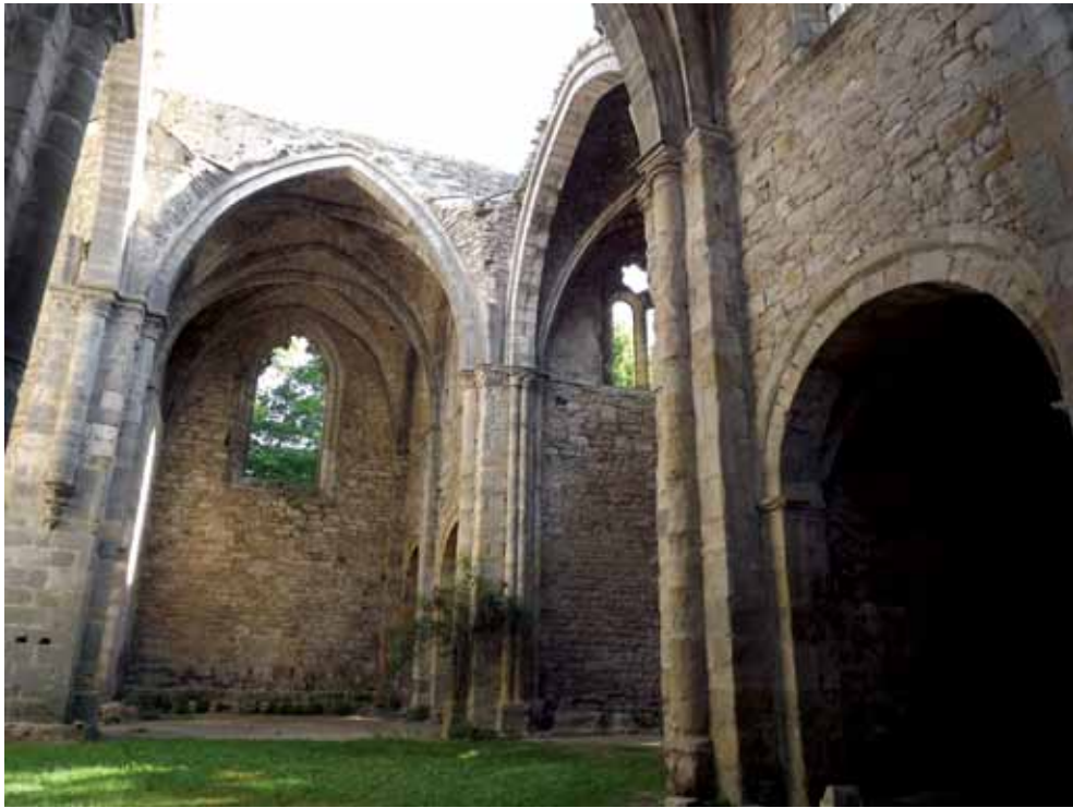
Saint-Martin-le-Vieil (11), ancienne abbaye de Villelongue : bancs en calcaire éocène à la base des élévations.
