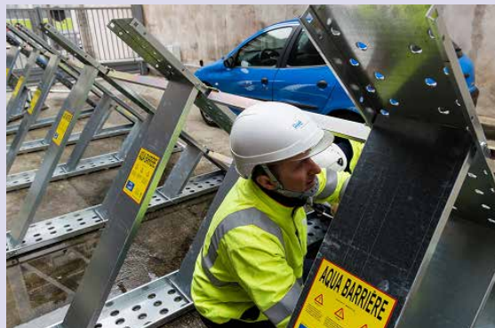
Installation d'aqua barrières au poste Javel à Paris
