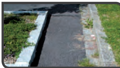
Les bordures et différences de niveau créent des recoins où il est difficile d'intervenir.
