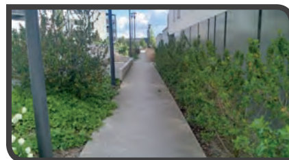
Une bande béton étroite, en retrait des massifs permet une gestion bien différenciée de l'allée et des massifs. Elle affirme deux espaces "à gérer".
