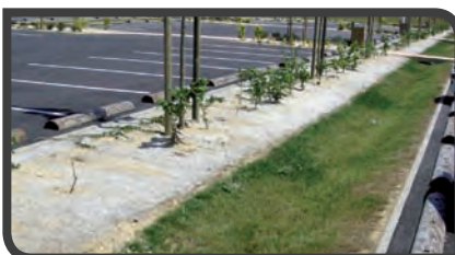
Un fossé sec avec des enrochements permet une bonne gestion des limites et favorise la collecte des eaux de surface et l'infiltration.
