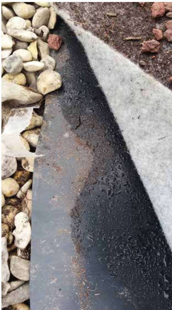
Couche anti-racines (toiture végétalisée en cours d'aménagement sur le collège Évariste-Galois (13 e ))
