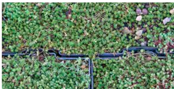
Modules pré-plantés sur le toit de l'atelier de travaux de la rue Raymond-Radiguet (19 e ) – photo Florence Morisson
