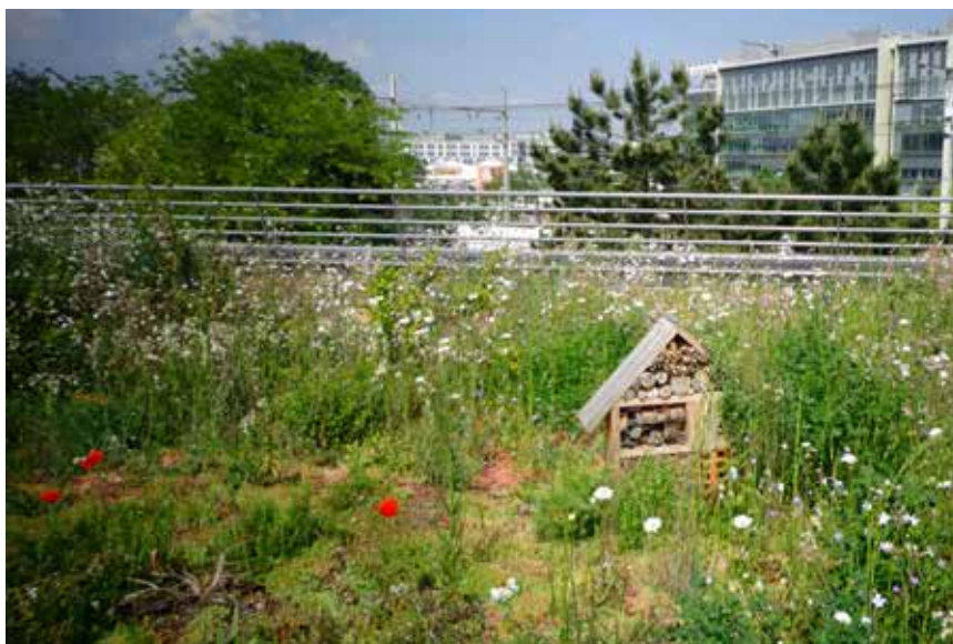
Des aménagements spécifiques et une sélection de plantes sauvages contribuent à faire du toit végétalisé du siège de GTM à Nanterre, réalisé par Topager, un refuge pour la biodiversité – photo Béatrice Jannic
