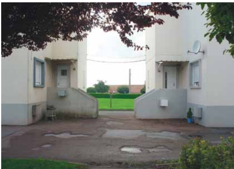
>>> Accès aux blocs C. Les porches reliant les maisonnettes jumelées entre elles et avec les immeubles, ont également été remplacés par de petits auvents en tôle.
