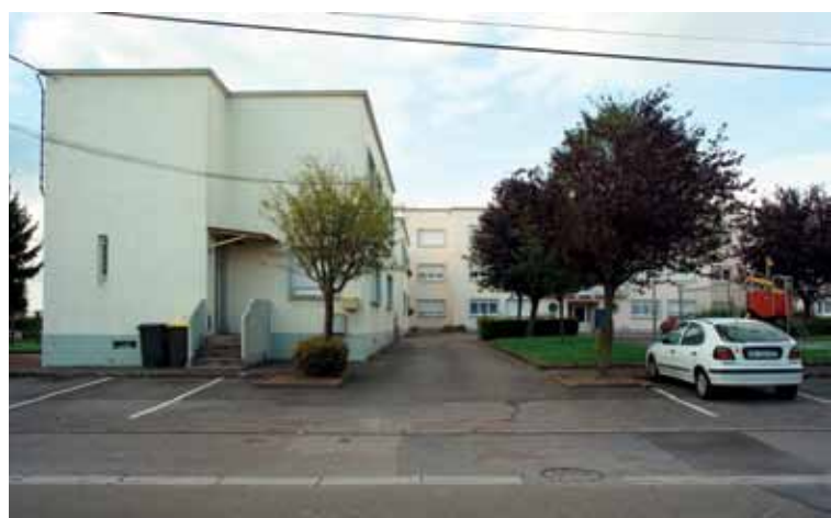
>>> Des places de stationnement envahissent les allées piétonnes.
