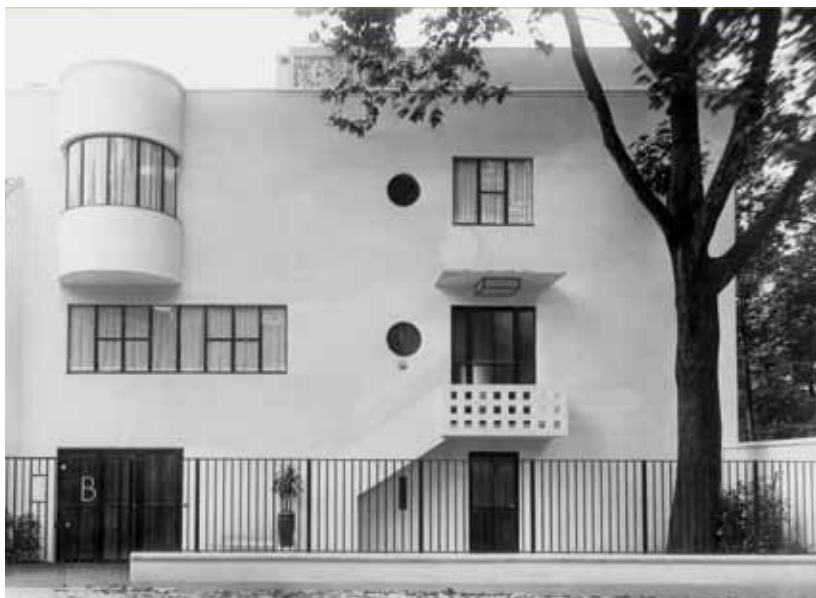
>>> Vue des façades sur rue des maisons d'Auguste Michel (en haut) et de M. Bomsel (en bas), Versailles (Yvelines), respectivement construites par André Lurçat en 1926 et 1925.
