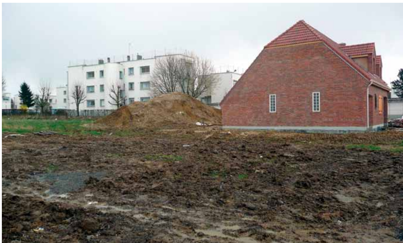
>>> Lotissement en cours de construction à l'arrière de la cité, 2011.
