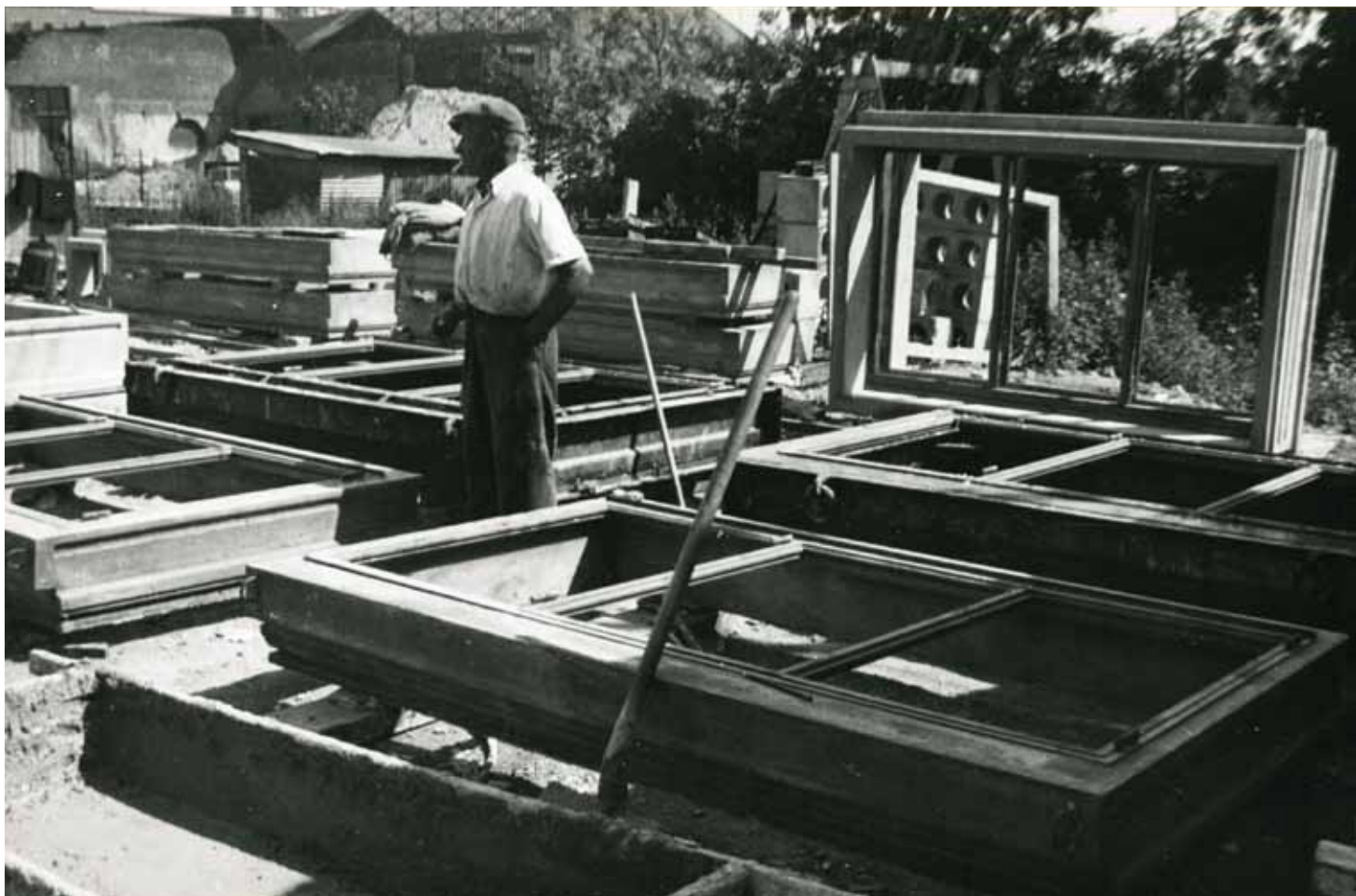
>>> Exemples de cadres préfabriqués avec menuiseries incorporées utilisés pour la reconstruction de Maubeuge.
