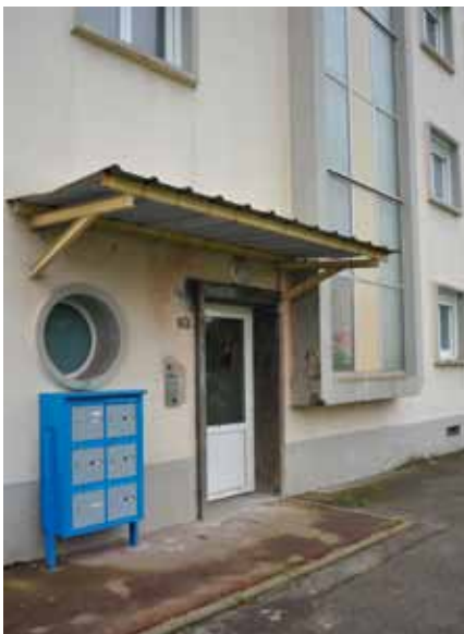
>>> Accès bloc B. Les auvents protégeant l'entrée des blocs B ont été détruits, remplacés par des ouvrages en métal.
