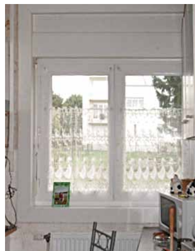
>>> À l'intérieur, les vides prévus dès l'origine pour l'encastrement des volets dans les linteaux n'ont pas été utilisés et le changement des fenêtres a ainsi occasionné une réduction de la luminosité.
