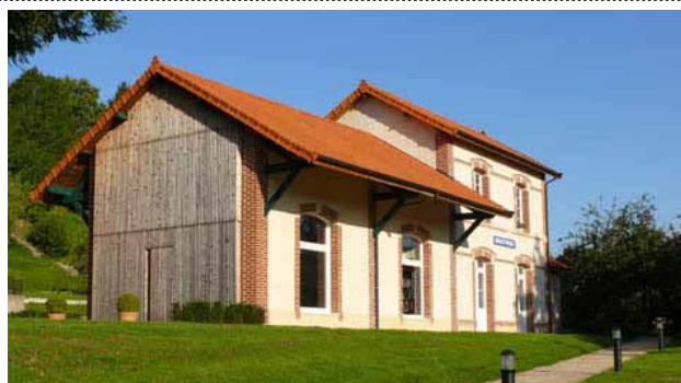
Reconversion d'une gare en bibliothèque - Val-de-Saône (76) - Jean-Michel LEFORESTIER, architecte (source CAUE 76)
