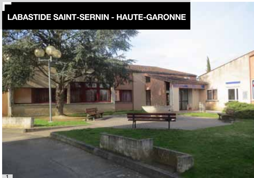
1. Façade principale de la salles des fêtes de Labastide Saint-Sernin (31)
