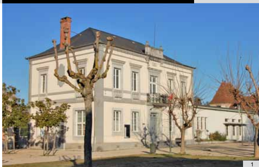
1. Façade principale sur la place centrale.
