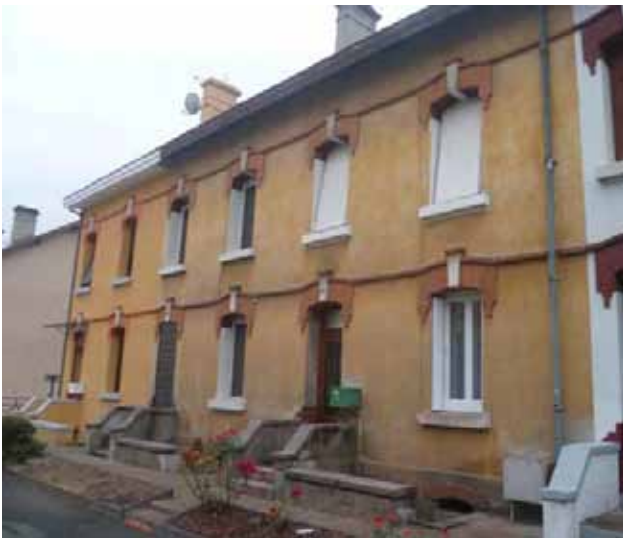
Logements ouvriers en bande à Viviez (12) - années 1920
