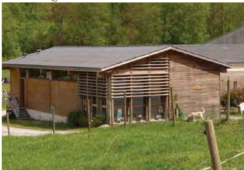
Bâtiment agricole à Sost
