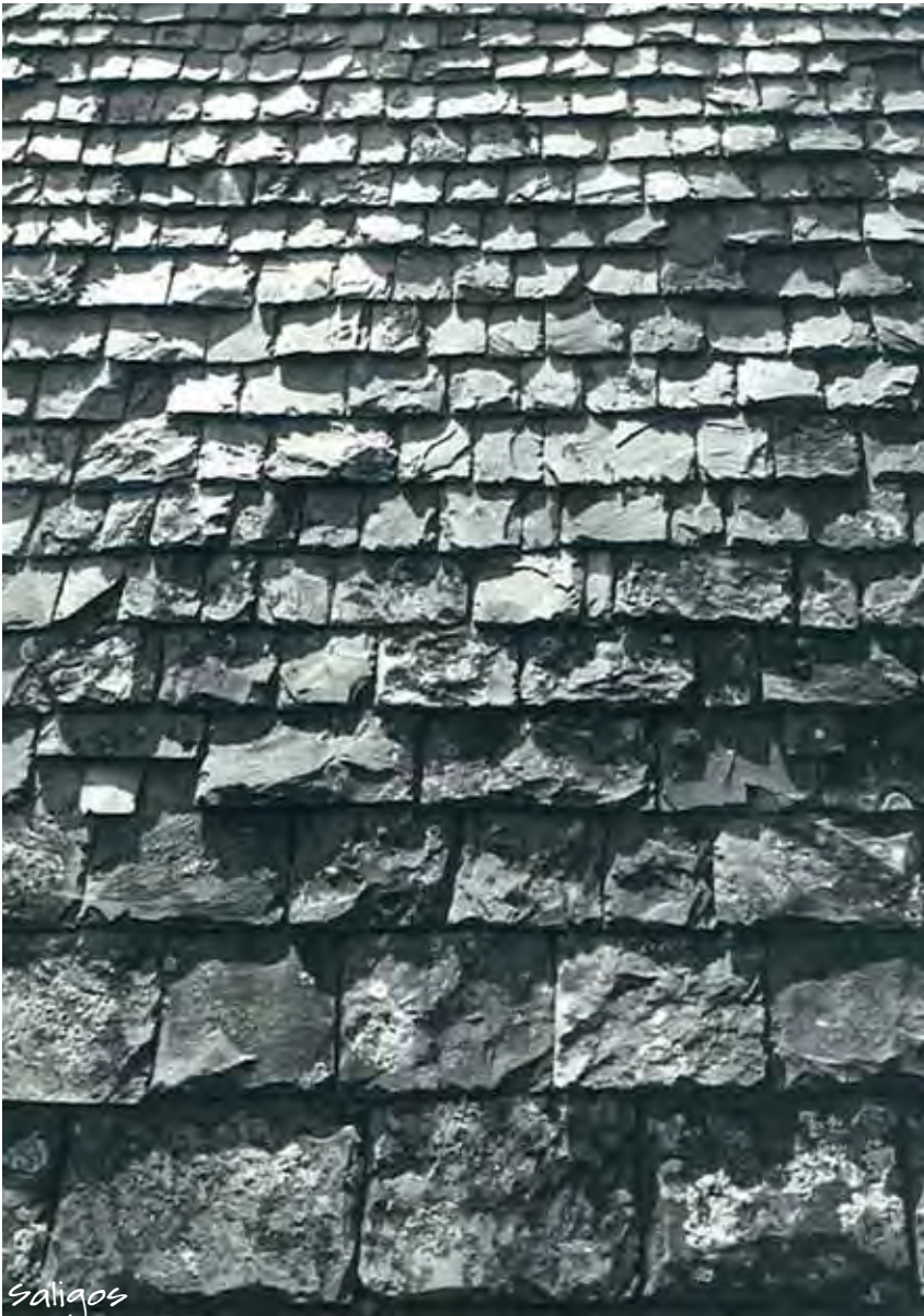
Toiture de schiste à pureau décroissant
