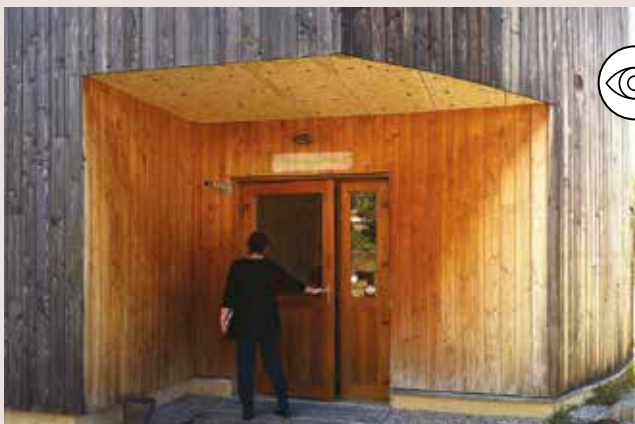
▲ L'entrée s'identifie sur la façade grâce à un perron en creux. Le bardage, ainsi protégé, a gardé sa couleur fauve et accentue le signal.
