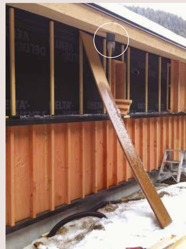
▲ Pour éviter une différence de coloration du bardage dès la livraison, le charpentier a posé une planche permettant à l'eau de s'évacuer sans risque d'éclabousser le bas du bardage.
