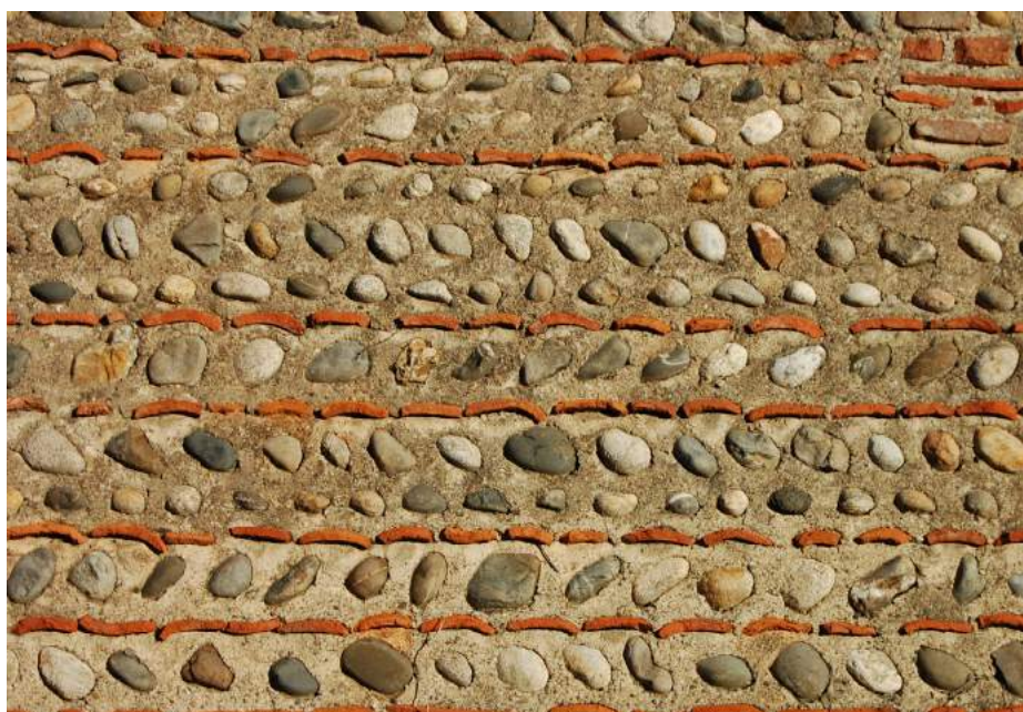
Alternance de galets et de briques à Sarriac-Bigorre
