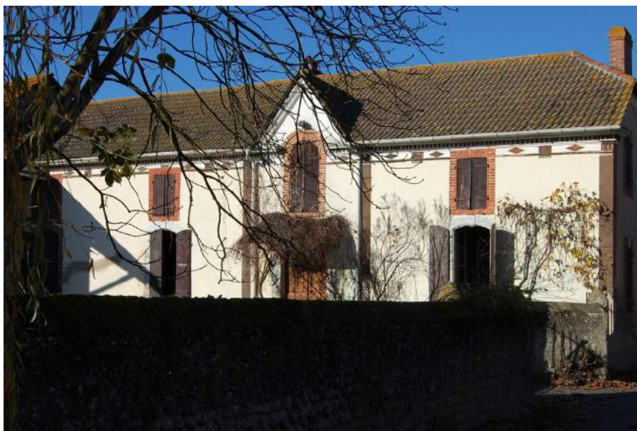
Maison à Sarriac-Bigorre. Murs bâtis, enduits et peints à la chaux
