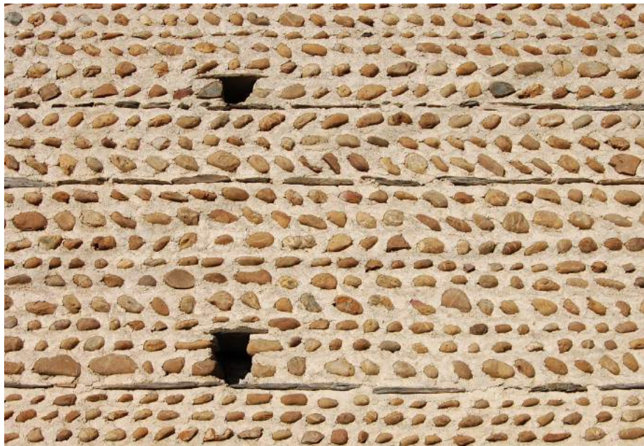
Alternance de galets et de schistes à Sarriac-Bigorre
