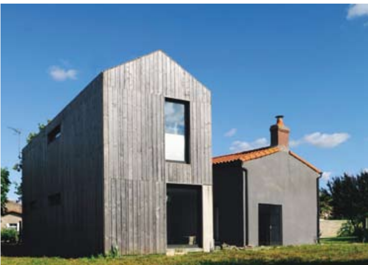
Maison « Laurel et Hardy », extension et réhabilitation , Magnum, architectes
