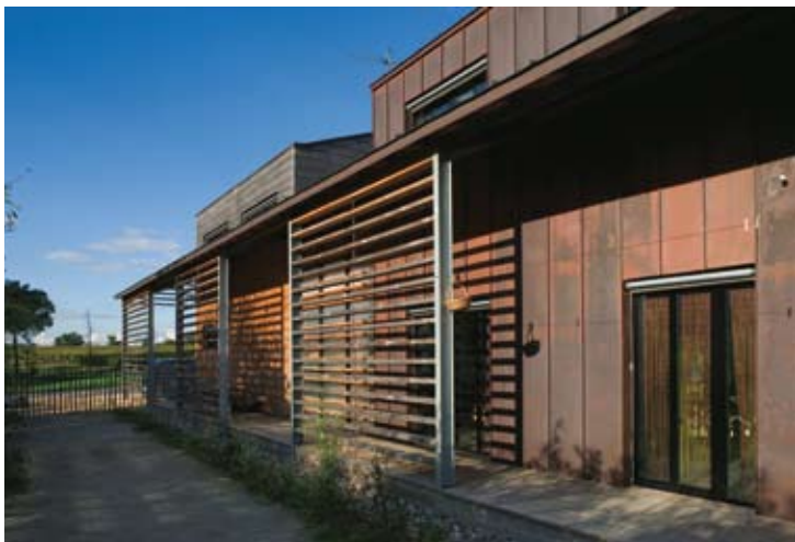
Maison/bureau, Haumont-Rattier, architectes
