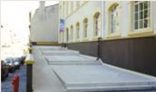
6| Archives municipales Architectes : Biaggi & Maurin Année : 1997 - 2001 Typologie : équipement culturel Adresse : 10 rue Clovis-Hugues, 13003 Marseille Image : © Biaggi & Maurin
