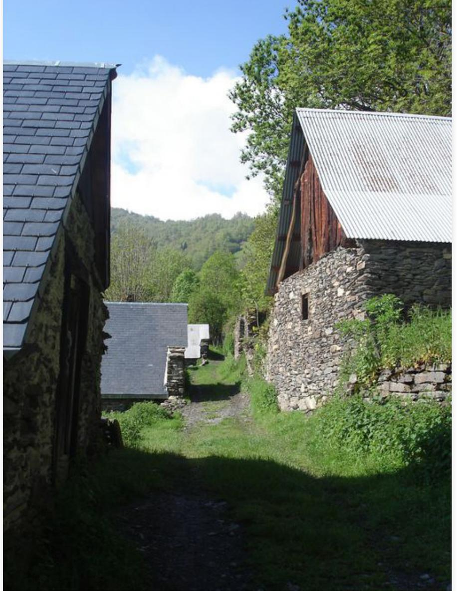
La couverture est en tuiles de terre cuite, en ardoises ou en lauzes posées sur une charpente en bois.
