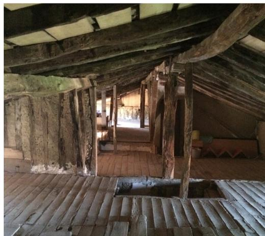
Les combles servent d'espace tampon qui protègent les zones habitables en atténuant les variations de température et d'humidité extérieures. Ils sont ventilés grâce à de petits percements fonctionnels : tabatières, fenestrons, lucarnes...
