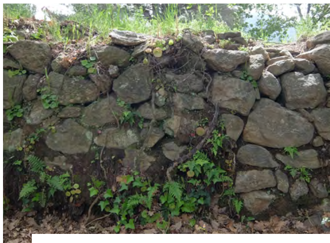
Au fil du temps et des dépôts aériens, les interstices se remplissent de terre. Muret de soutènement en limite de champs à Laroque des Albères (66). | © Sandrine LARRAMENDY
