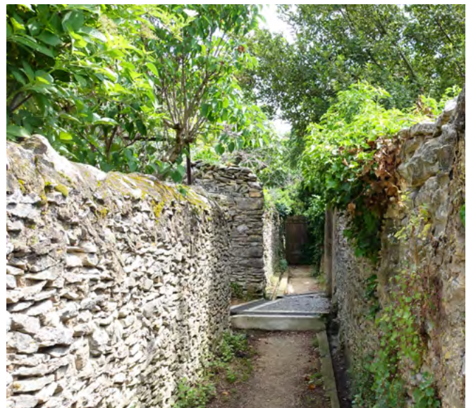
Au centre de Villes-sur-Auzon (83), un quartier de petits jardins entourés de murs en pierres sèches, les «Pous de Foro», est cultivé par les habitants qui ne possèdent pas de jardins. Un réseau de caniveaux permet de les arroser en utilisant l'eau de la fontaine.
