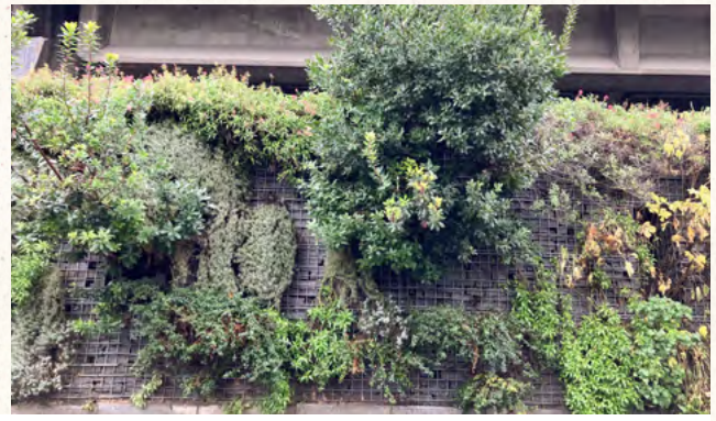
Mur en gabion de la rue d'Oradour-sur-Glane à Paris (75), au moment de sa construction en 2008 et avant installation des végétaux. | © Google - Le même gabion en 2024, la végétation s'est bien implantée et recouvre par endroit le gabion. | © Sandrine LARRAMENDY
