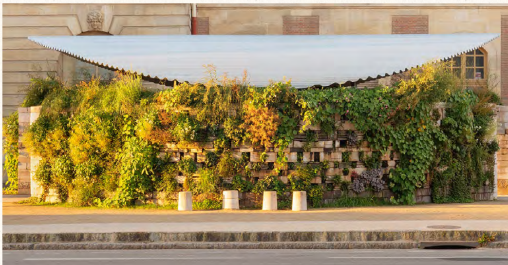
Le pavillon est de forme circulaire et mesure 12 m de diamètre et 2,20 m de haut. L'appareillage est de l'opus assisé. | © Chartier Dalix
