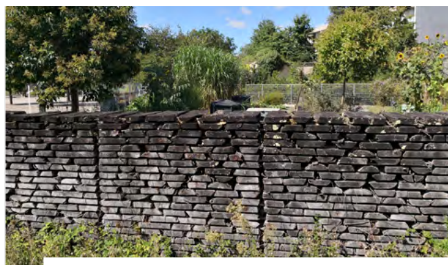
Mur d'enceinte du jardin botanique de Bordeaux (33). Il est constitué d'un empilement de planches de bois brutes. Conçues par Catherine MOSBACH, paysagiste DPLG urbaniste et Françoise-Hélène JOURDA, architecte. | © Marc BARRA
