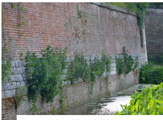
Les remparts de la Citadelle de Lille (59) datent de 1763. Ils sont réalisés en brique avec un soubassement en grès dur. Ils abritent une flore et une faune intéressante. | © Ville de Lille
