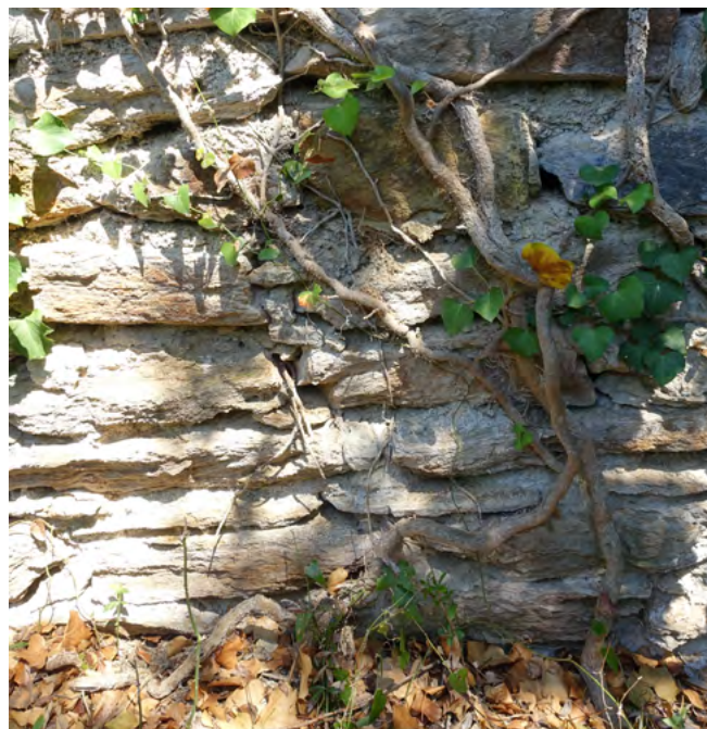
La plupart du temps, le lierre ne pénètre pas dans la structure des murs, mais se contente d'en parcourir la surface afin de prendre de la hauteur. Un lierre qui reste ainsi en périphérie, comme c'est le cas sur cette photo, ne pose pas de problème si le mur est stable. | © Sandrine LARRAMENDY
