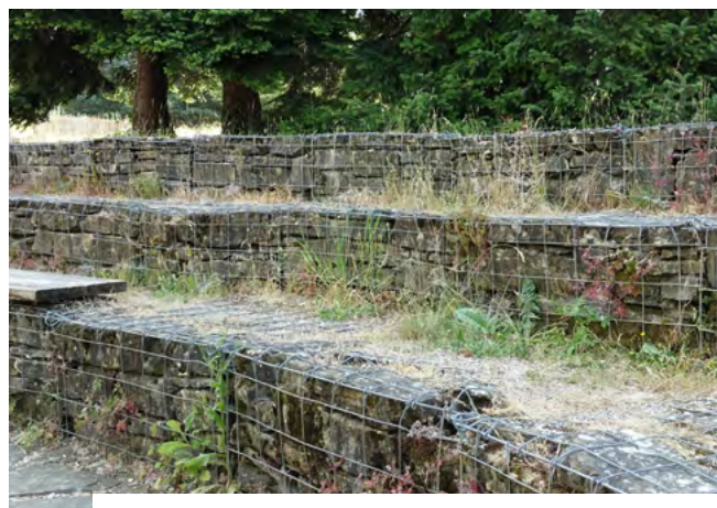
Ces gradines en gabion sont un peu colonisées par la végétation spontanée grâce à l'ajout de terre, notamment au pied, cependant la diversité reste assez faible. Gradines du théâtre de verdure de l'Ecole de paysage Luillier en Suisse. | © Sandrine LARRAMENDY
