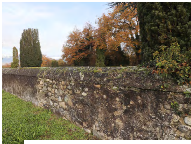
Autre exemple de mur crépi qui accueille des plantes au fil du temps : un long mur de séparation entre un cimetière et des champs à Laconnex (Suisse). Ici le crépis tombe un peu laissant apparaître les pierres. | © Hélène BURGISSER HINDEN.
