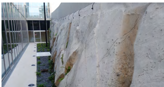
Exemple de mur en béton coulé à Suresnes (92). © Alice DELUDE
