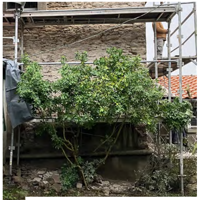
Chantier de ravalement de façade avec un enduit à la chaux avec conservation d'un arbuste existant (Oranger du Mexique) malgré l'échafaudage. | © Sandrine LARRAMENDY
