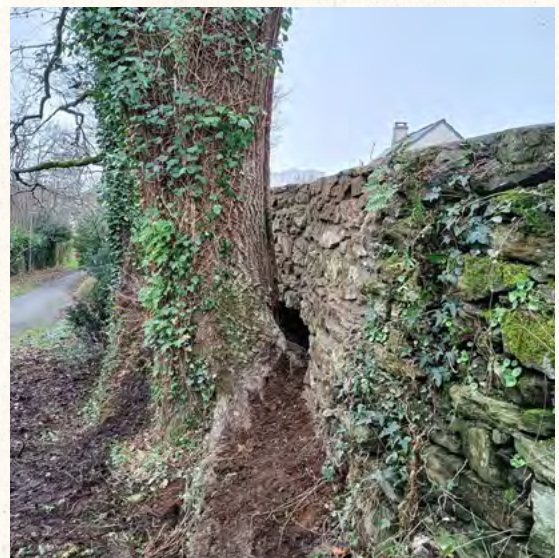
La cohabitation d'un chêne et d'un mur de pierres maçonnées à Nantes (44). 1 © François FREYTET, ville de Nantes (44)
