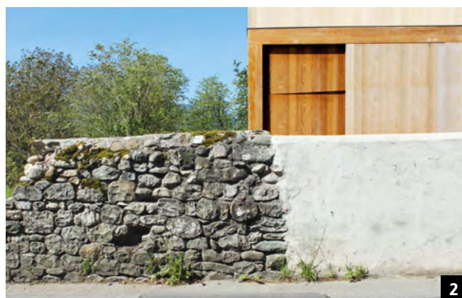
1 - Sur ce mur, le choix de refaire seulement les joints qui nécessitaient une consolidation lui permet de garder tout son intérêt pour la vie et de maintenir la majorité des espèces déjà présentes. 2 - Lors d'une réfection complète comme effectuée sur une portion du mur à droite toute la capacité d'accueil du mur est perdue pour de nombreuses années. Murs à Satigny (1) et Chancy (2), Canton de Genève (Suisse).
