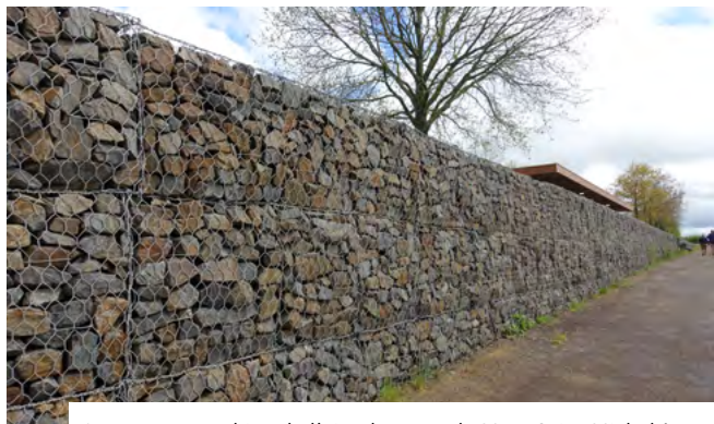
Long mur en gabion de l'aire de repos du Mont Saint-Michel à Tirepied-sur-Sée (50). Conceptrice : Laure PLANCHAIS, paysagiste conceptrice. | © Sandrine LARRAMENDY
