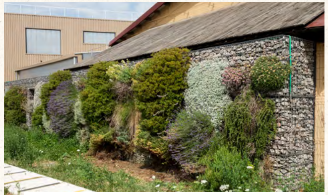
Le gabion en parement de la façade de l'atelier technique de la gare de triage SNCF de Villeneuve-Saint-Georges (94). | © Alexandre PETZOLD
