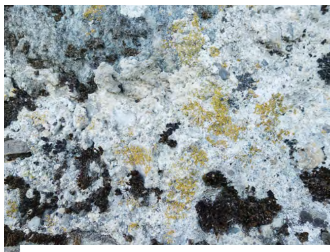
La rugosité de la surface des pierres est favorable au développement des mousses et des lichens. Mur de la Perle du Lac à Genève (Suisse). | © Sandrine LARRAMENDY
