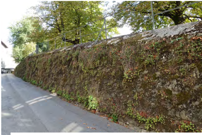
La Rampe de la Treille est un mur de soutènement au-dessus duquel se trouve un espace public. | © Sandrine LARRAMENDY
