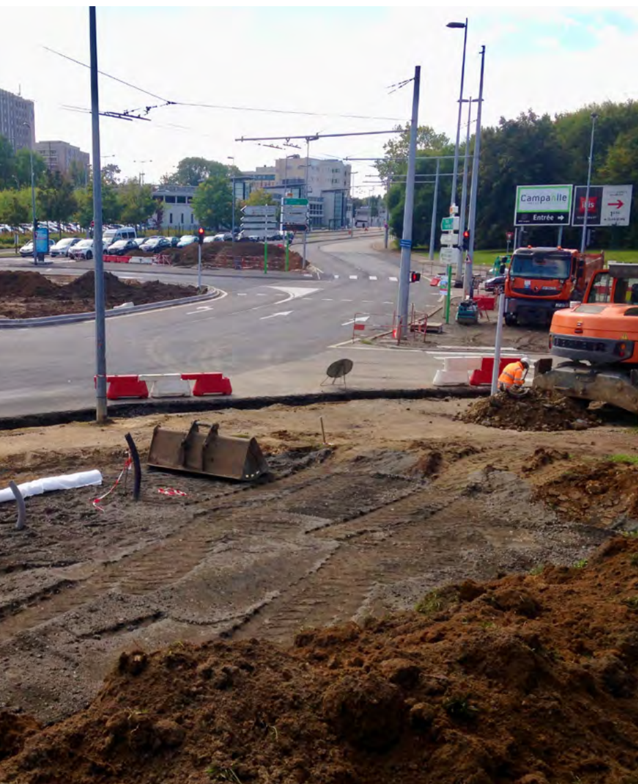
Travaux de désimpermeabilisation, Métropole du Grand Nancy. / C. Schwartz
