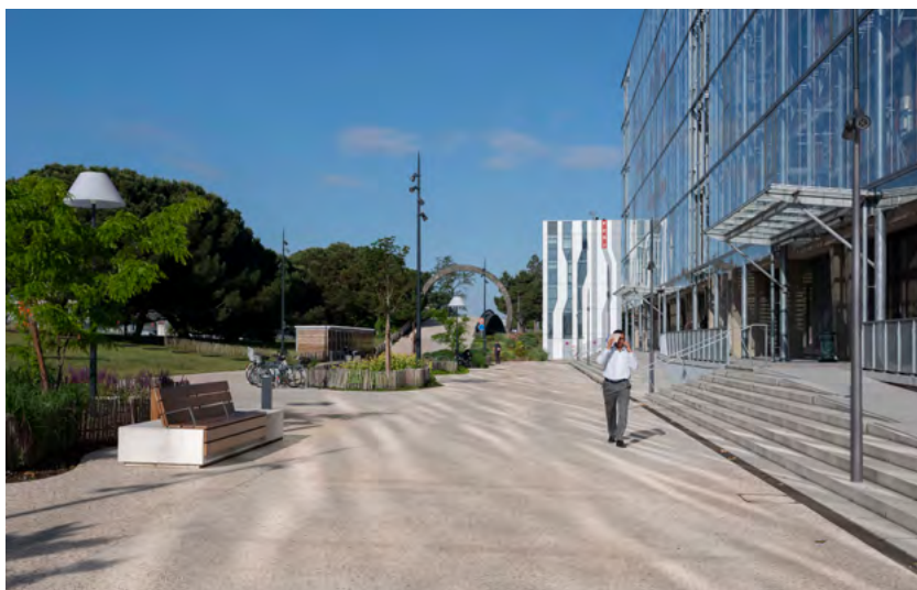
Surface scellée par du béton, Campus Béthanie à Talence (33). / SCE
