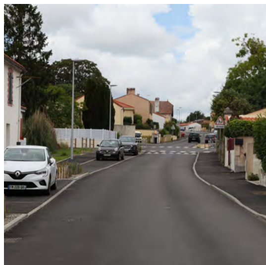
Voirie, stationnement et trottoir en enrobé, Bourg Sous La Roche (85). / SCE
