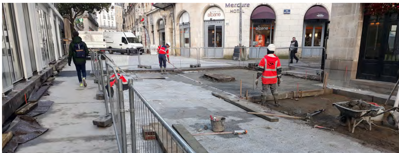
Pose d'une dalle béton avant pavés, rue du Couëdic à Nantes (44). / SCE
