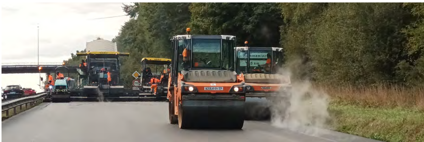
Travaux et pose d'enrobé sur route. / SCE
