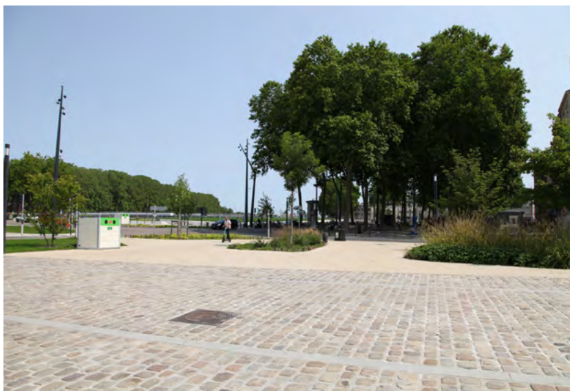
Revêtement pavé joint-béton, Projet Cœur de Maine à Angers (49). / SCE
