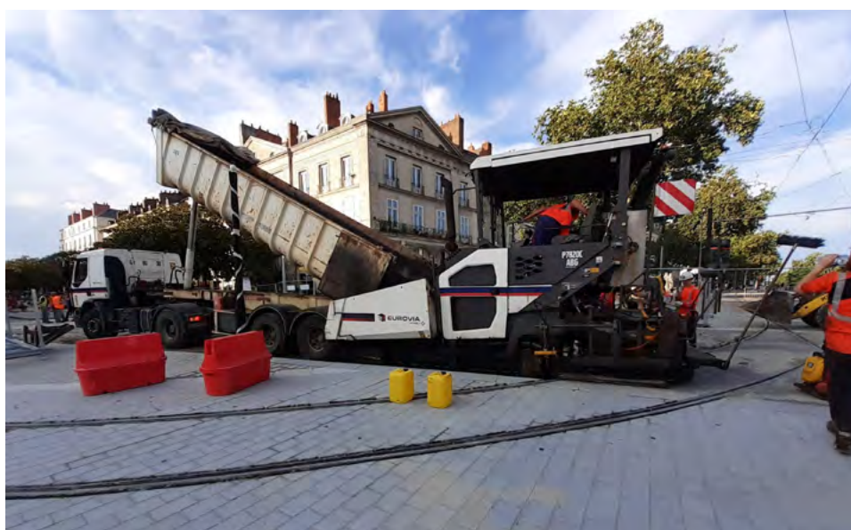
Travaux sur voirie et sur voie de tram à Nantes (44). / SCE
