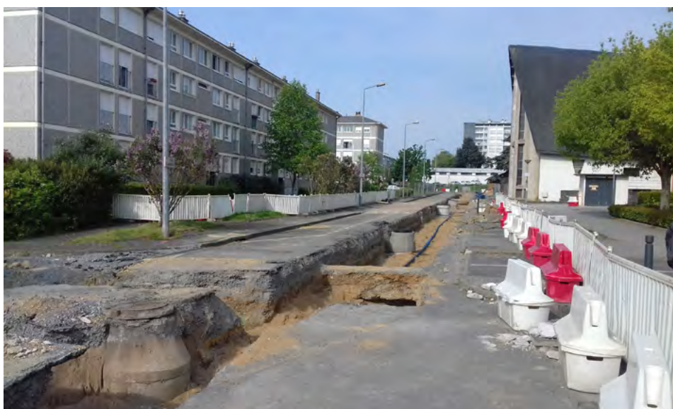
Travaux sur réseaux. / SCE
